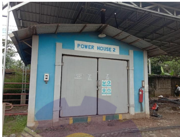
Gambar 1.5 Power House (Sumber: Dokumentasi, 2022)
