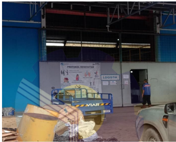
Gambar 1.7 Gudang / Logistik (Sumber: Dokumentasi, 2022)
