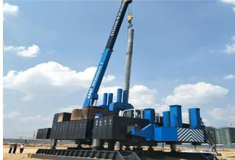
Gambar 3.8 pekerjaan pemasangan tiang pancang
