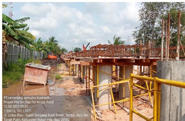
Gambar 3.13 penulangan pile cap
