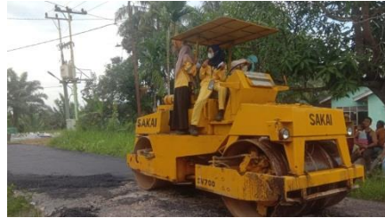
Gambar 2.3 Proses pemadatan menggunakan tandem roller
