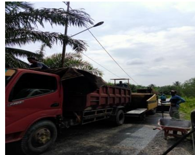
Gambar 2.6 proses penuangan aspal
