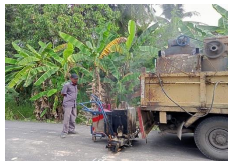
Gambar 2.10 Mesin Aplikator Marka Jalan
