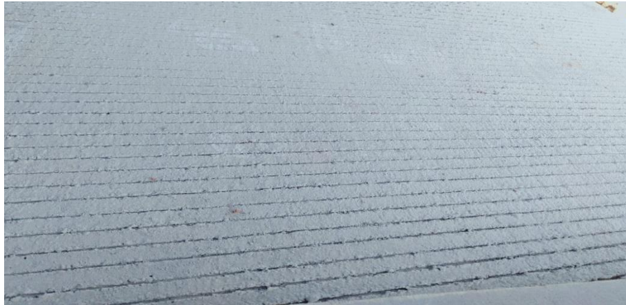
Gambar 3.18. Slab beton yang sudah di grooving
