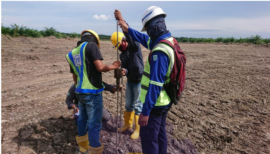
Gambar 3.3. Pengujian DCP pekerjaan clearing
