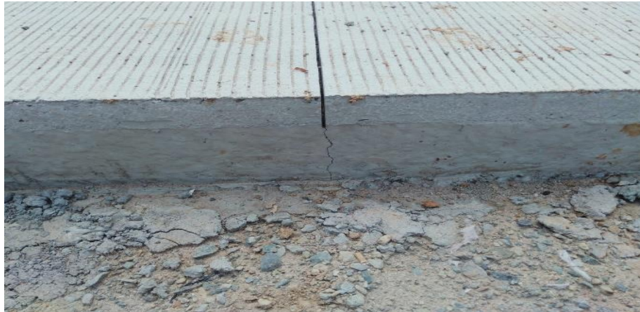
Gambar 3.20. Hasil pemotongan beton
