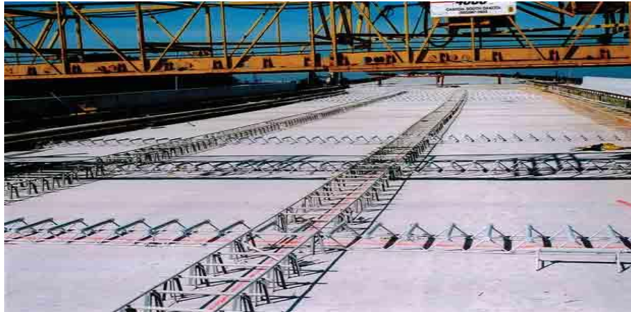
Gambar 3.15. Pemasangan tie dan dowel bar
