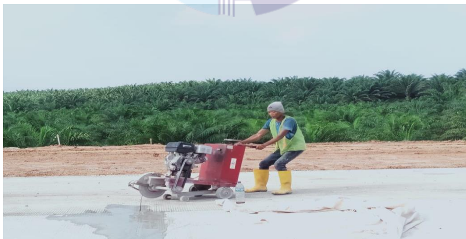
Gambar 3.19. Pemotongan segmen beton
