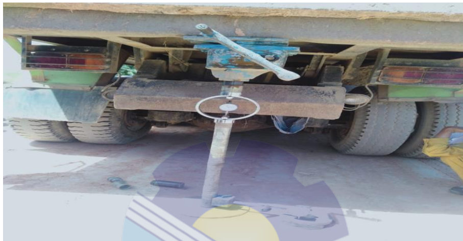
Gambar 3.6. Pengujian CBR lapangan
