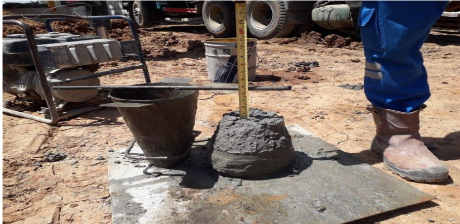
Gambar 3.12. Pengecekan slump beton
