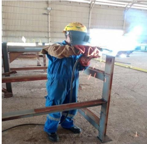
Gambar 2. 26 Pembuatan Rak Hanger
