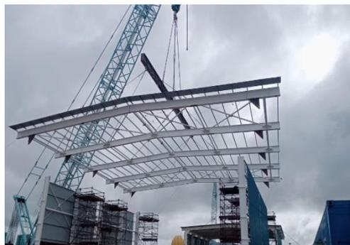
Gambar 2. 40 Pemasangan Bagian Atas
