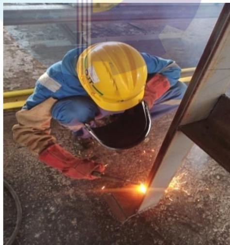
Gambar 2. 27 Proses Pengelasan Rak Hanger
