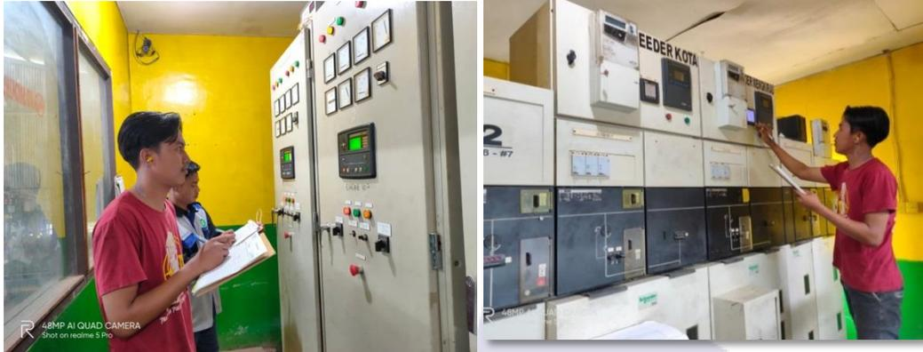
Gambar 2.15 Mencatat data *Feeder* dan *Panel synhron*
