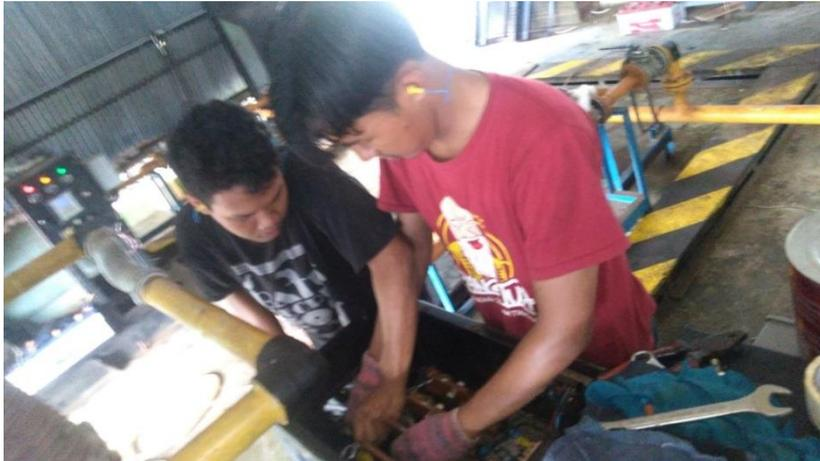
Gambar 2.14 Pemasangan *cabl* Generator
