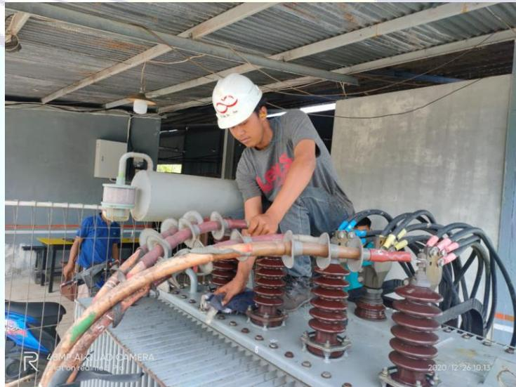
Gambar 2.11 Pengisian *Oil* Pendingin Pada Transformator 1600 KVA
