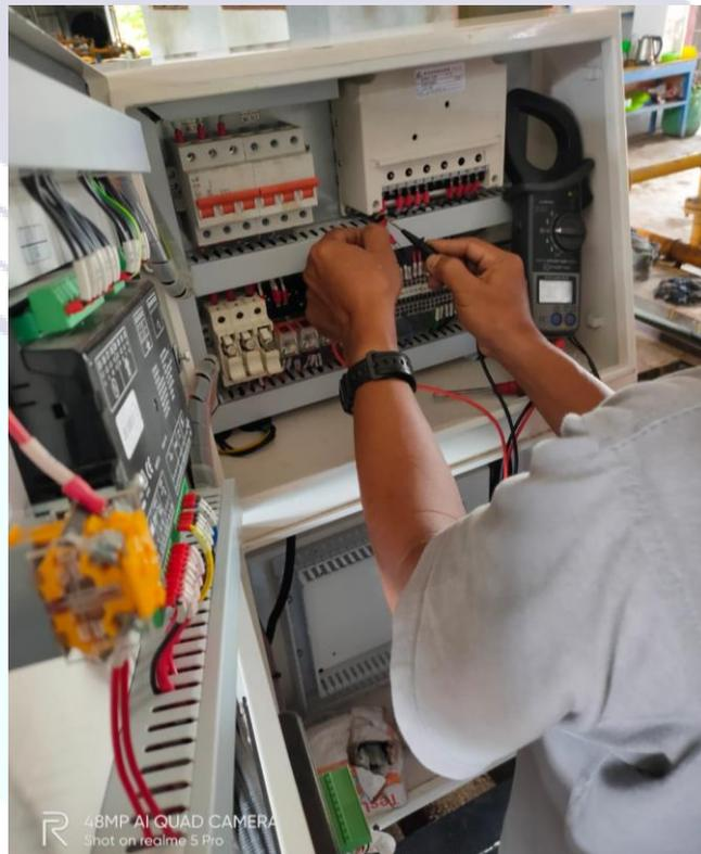
Gambar 3. Memeriksa dan mengukur tegangan panel *engine*
