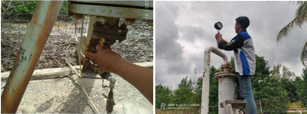
Gambar 2.3 Membuang air pada saringan gas ( *scrubber* )
