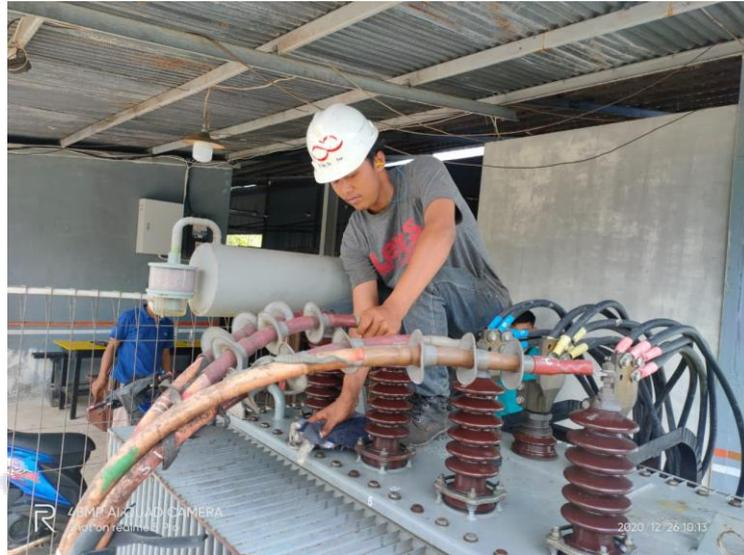
Gambar 3.2 Membersihkan dan menambahkan *Oil* Pendingin Pada Transformator 1600 KVA
