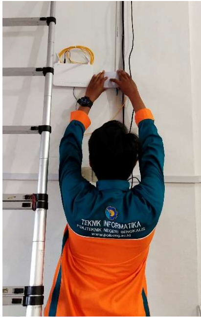
Gambar 3.1 Pemasangan IndiHome pelanggan
