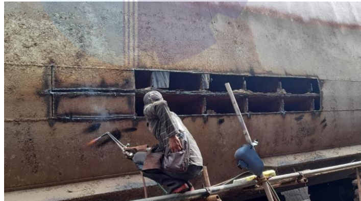
Gambar 2.7 Pembongkaran Plat Lambung Trifosa
