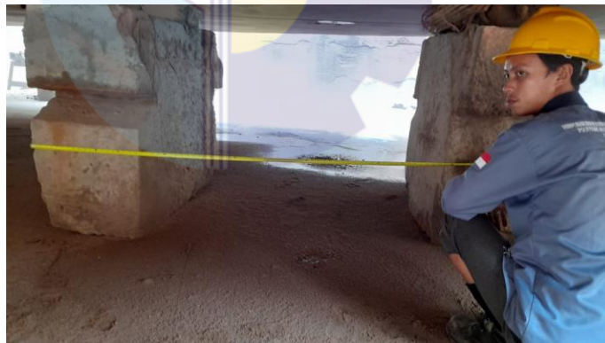
Gambar 2.34 Pengukuran jarak antar Stop Block
