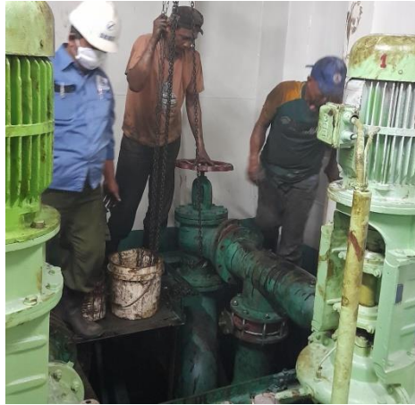
Gambar 2.12 Pembongkaran Pipa Sea Chest
