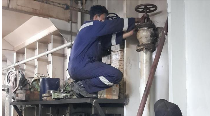
Gambar 2.14 Pemasangan Valve
