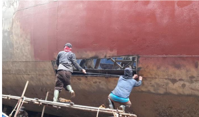
Gambar 2.6 Pembongkaran Plat
