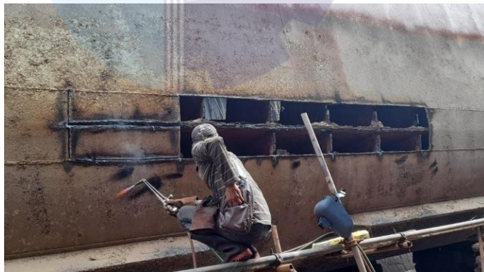
Gambar 2.7 Pembongkaran Plat Lambung Trifosa
