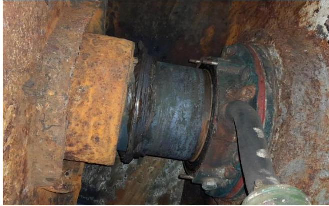
Gambar 2.17 Pembongkaran Flands Kopling
