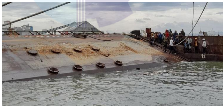
Gambar 2.32 Perbaikan Pintu Graving Dock
