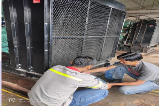
Gambar 2.12 Perawatan radiator pada engine D# 3
