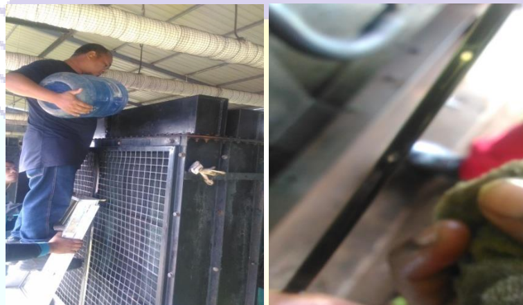
Gambar 2.10 Pengecekan oli dan Pengisian air radiator
