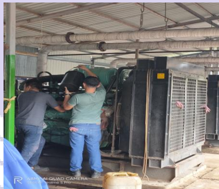
Gambar 2.5 Pergantian oil engine pada D#4
