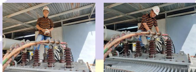
Gambar 5.16 Penambahan Air TRAFO Sumber : (Dokumentasi penulis 2020)
