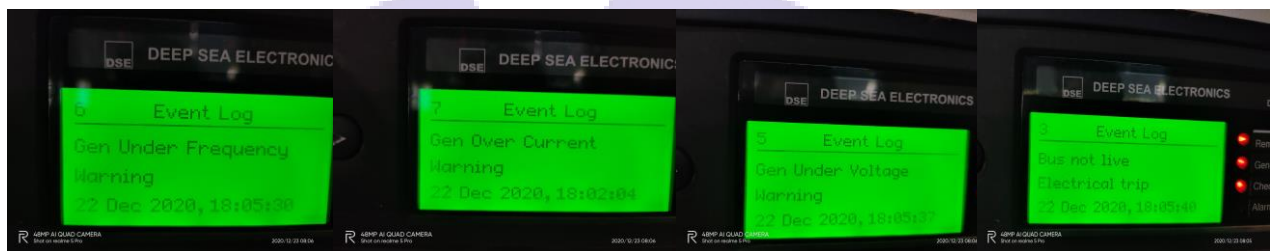
Gambar : 5.19 Gangguan pada Generator type Stamford saat Berbeban (sumber : Dokumentasi Penulis 2020)
