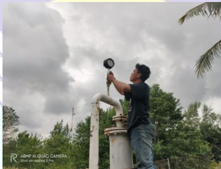
Gambar 2.3 Membuang air pada filter saringan gas ( scrueaber )
