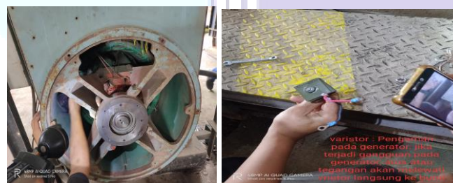
Gambar 2.17 Pergantian Varistor yang rusak D#8
