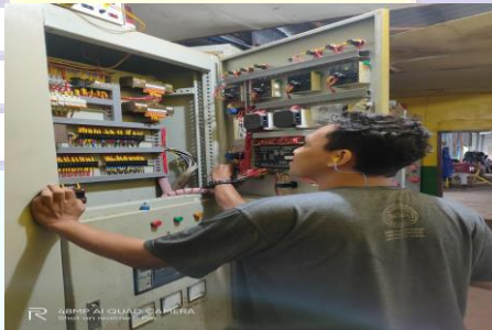
Gambar 3.32 Memeriksa Kabel RSTN Sumber : (Dokumentasi penulis 2020)
