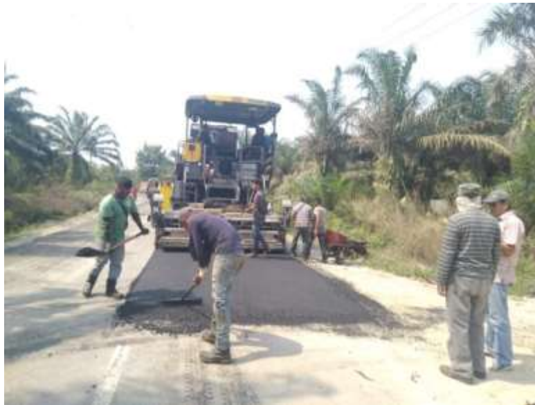
Gambar 3.1.2.4.1 pekerjaan penghambaran laston AC-BC
