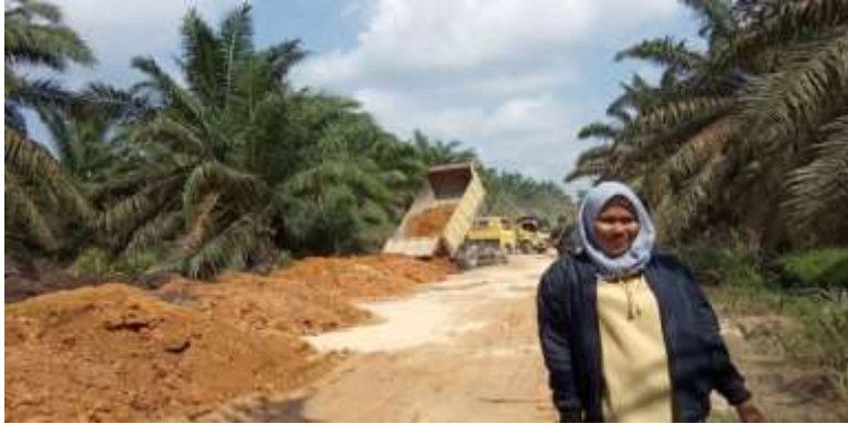
Gambar 3.1.2.5.2 foto lokasi pekerjaan tanah timbunan
