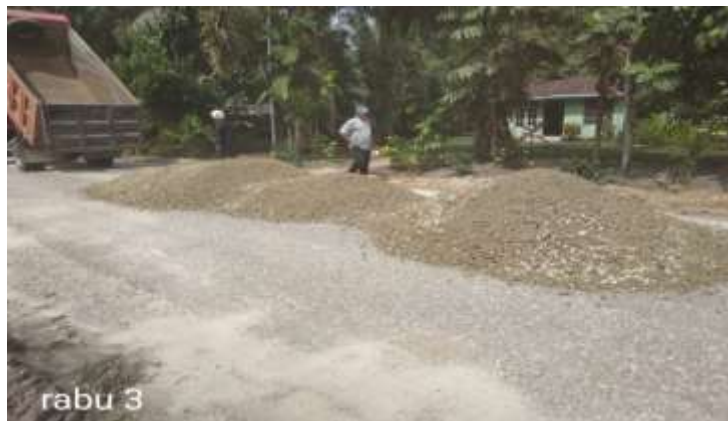
Gambar 3.1.2.2.1 pekerjaan lapisan pondasi agregat kelas A
