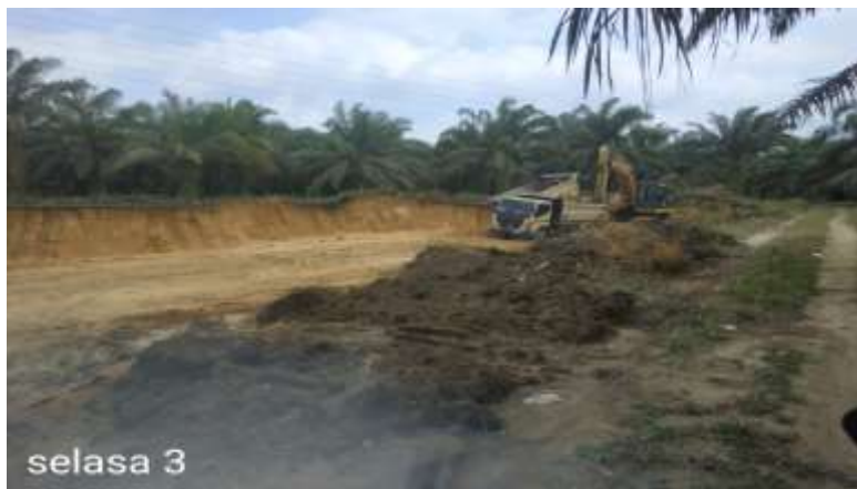
Gambar 3.1.2.5.1 pengambilan tanah timbunan dikuari
