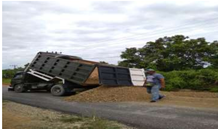
Gambar 3.1.2.1.1 pekerjaan lapisan pondasi agregat kelas B
