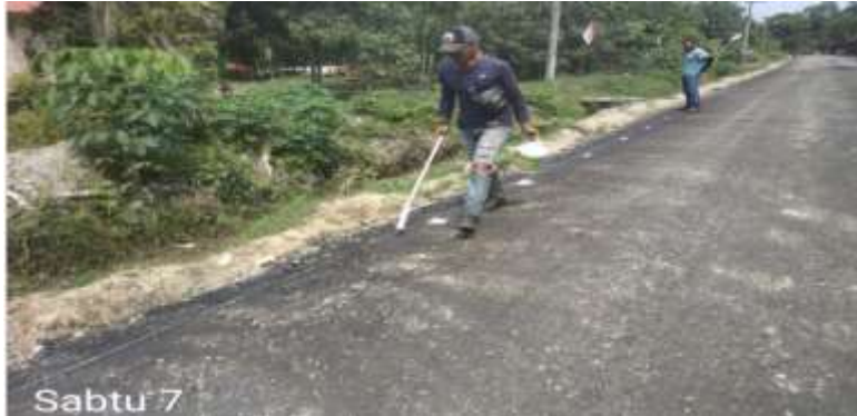
Gambar 3.1.2.3.1 pekerjaan lapisan resap peningkatan aspal cair dan lapisan perekat aspal cair
