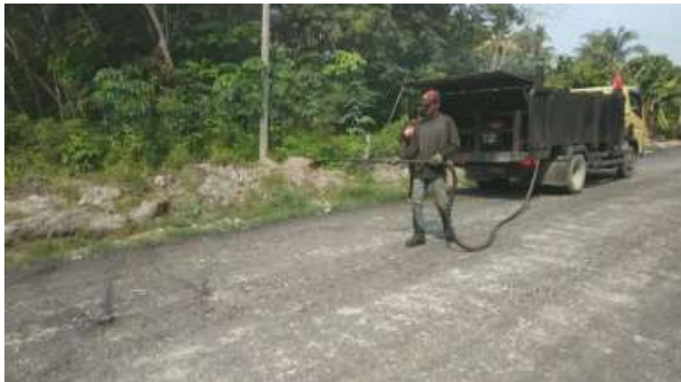
Gambar 3.1.2.3.2 pekerjaan lapisan resap peningkatan aspal cair dan lapisan perekat aspal cair
