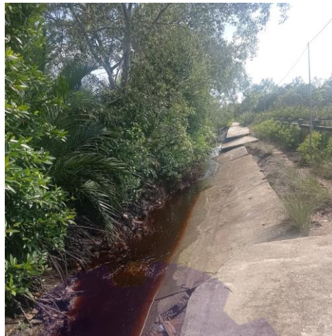
Gambar 1.2 Kondisi jalan yang hancur akibat lonsor nya tanah Sumber : Dokumentasi Lapangan Tugas Akhir, 2020.
