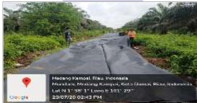
Gambar 3.1 Pemasangan Plastik Geotek/ Woven
