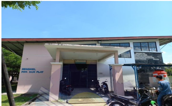
Gambar 1.2 Gedung bengkel las, pipa, dan plat
