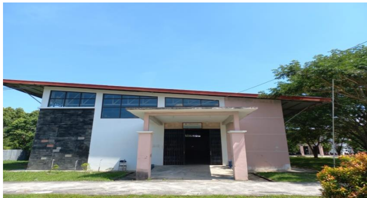
Gambar 1.3 Gedung bengkel kapal non baja
