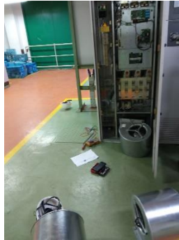
Gambar 2.4 Penggantian Fan di Fiberline 2
