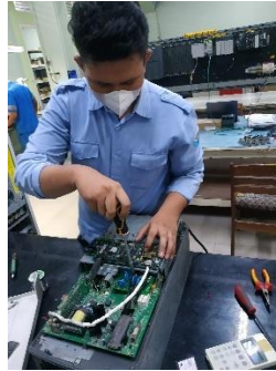
Gambar 2.13 Bongkar dan Pengecekan VSD ACS-800
