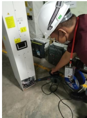
Gambar 3.17 Kegiatan Cleaning Sebagai Preventive Maintenance (Sumber: Dokumentasi PT. Riau Andalan Pulp and Paper Pangkalan Kerinci, 2022)
