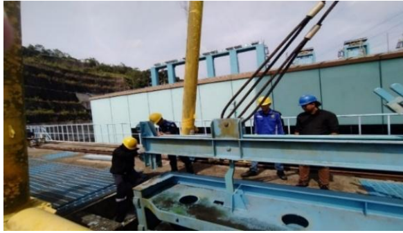
Gambar 2. 37 Pemindahan stop bloc pada unit 2 (Sumber: Unit Layanan PLTA Koto Panjang. 2022)
