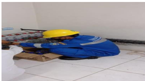
Gambar 2. 3 Perawatan air Batrai (Sumber: Unit Layanan PLTA Koto Panjang. 2022)
