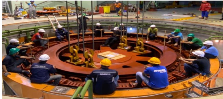
Gambar 3. 2 Konstruksi Generator Sinkron (Sumber: Arsip Perusahaan)
