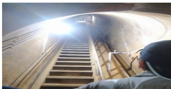
Gambar 2. 36 Pengecekan debit air pada dam galeri
