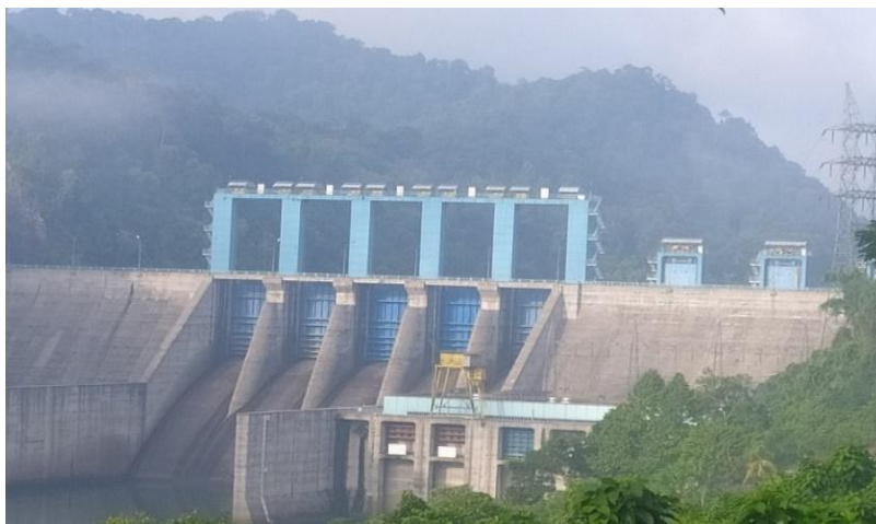
Gambar 1. 1. Unit Layanan PLTA Koto Panjang (Sumber: Unit Layanan PLTA Koto Panjang. 2022)
