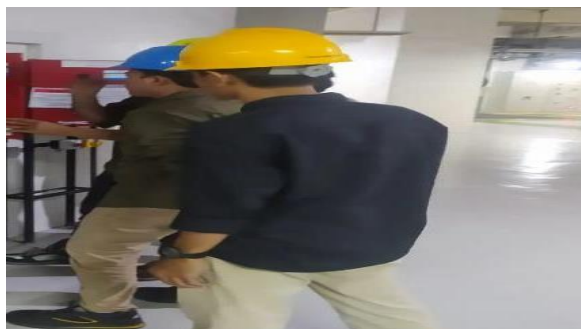
Gambar 2. 16 Monitoring pada CO 2 generator (Sumber: Unit Layanan PLTA Koto Panjang. 2022)
