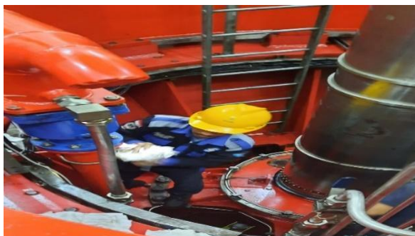
Gambar 2. 48 Perawatan pada area top cover
