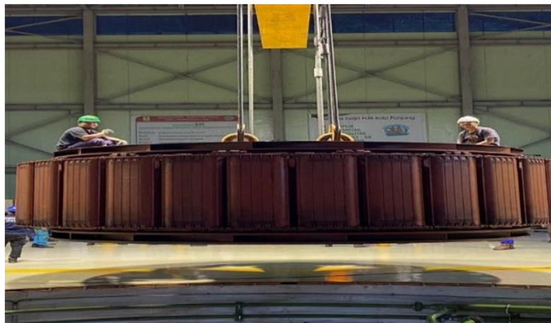
Gambar 3. 5 Rotor PLTA Koto Panjang (Sumber: Arsip Perusahaan)
