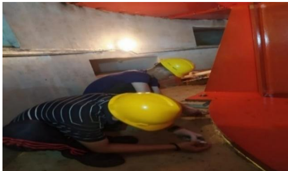
Gambar 2. 50 Pembersihan ruang brek dan pemberian silicon (Sumber: Unit Layanan PLTA Koto Panjang. 2022)
