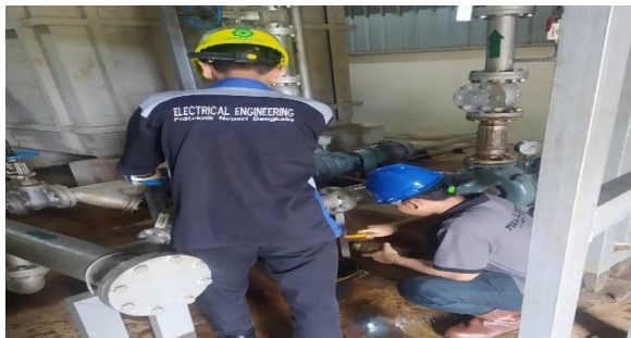
Gambar 2. 10 Pembersihan basket trainer (Sumber: Unit Layanan PLTA Koto Panjang. 2022)
