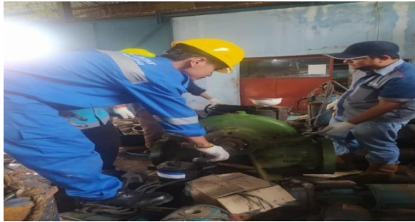
Gambar 2. 4 Pembongkaran Cover pompa raw Water (Sumber: Unit Layanan PLTA Koto Panjang. 2022)
