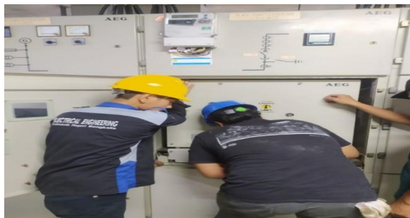
Gambar 2. 46 Pelepasan PMT dan pemasangan grounding ( Sumber : Unit Layanan PLTA Koto Panjang. 2022)
