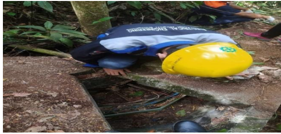
Gambar 2. 25 Pengecekan pada kabel kontrol (Sumber: Unit Layanan PLTA Koto Panjang. 2022)
