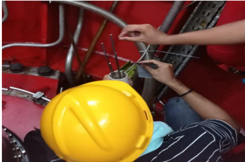
Gambar 3. 12 Perawatan elektroda (Sumber: Unit Layanan PLTA Koto Panjang. 2022)
