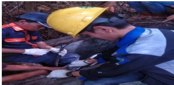
Gambar 2. 26 Maintenance pada kabel bawah tanah menuju GI (Sumber: Unit Layanan PLTA Koto Panjang. 2022)
