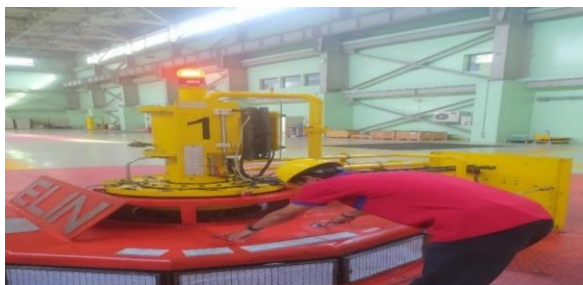
Gambar 2. 30 Pembersihan area slip ring unit 1 (Sumber: Unit Layanan PLTA Koto Panjang. 2022 )
