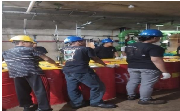
Gambar 2. 39 Pemindahan oli dari unit 2 PLTA (Sumber: Unit Layanan PLTA Koto Panjang. 2022)
