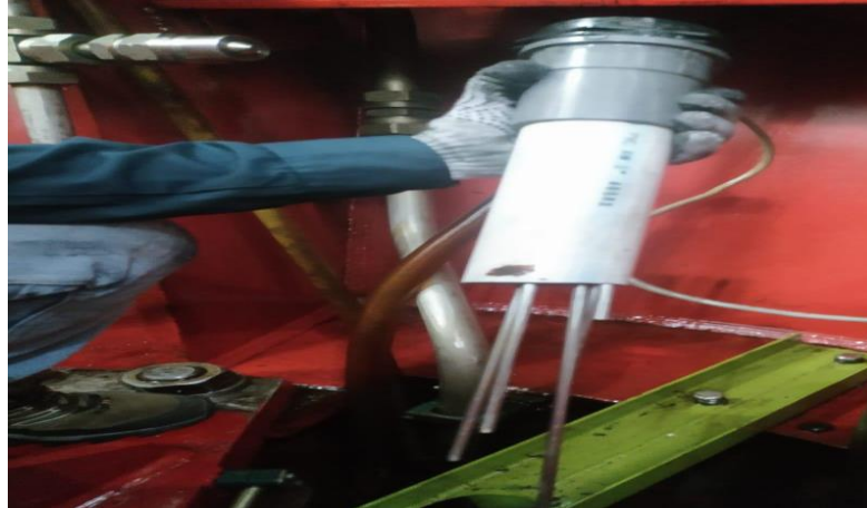
Gambar 3. 6 sensor level switch (Sumber: Unit Layanan PLTA Koto Panjang. 2022)
