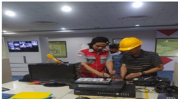
Gambar 2. 57 Maintenance CCTV (Sumber: Unit Layanan PLTA Koto Panjang. 2022)
