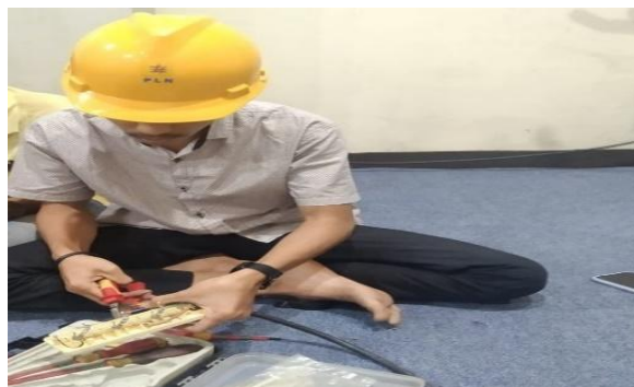
Gambar 2. 21 Pemasangan instalasi (Sumber: Unit Layanan PLTA Koto Panjang. 2022)
