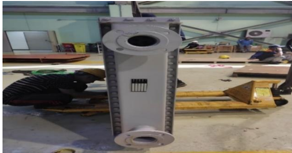
Gambar 2. 42 Pemasangan air cooler ke generator (Sumber: Unit Layanan PLTA Koto Panjang. 2022)
