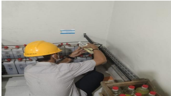
Gambar 2. 20 Pengisian dan pengukuran tegangan pada baterai (Sumber: Unit Layanan PLTA Koto Panjang. 2022)
