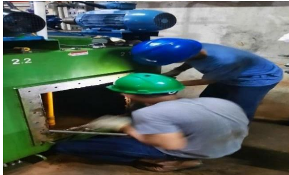
Gambar 2. 44 Maintenance pada arepa pump shaft seal ( Sumbe : Unit Layanan PLTA Koto Panjang. 2022)
