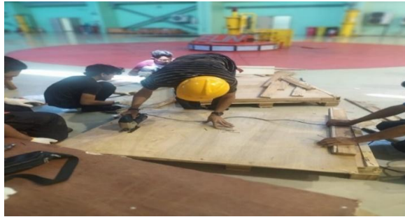
Gambar 2. 9 Pembuatan box pompa row Water (Sumber: Unit Layanan PLTA Koto Panjang. 2022)
