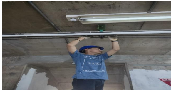
Gambar 2. 43 Perawatan pada instalasi pompa air (Sumber: Unit Layanan PLTA Koto Panjang. 2022)
