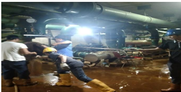
Gambar 2. 14 Maintenance pada HE (heat exchanger) (Sumber: Unit Layanan PLTA Koto Panjang. 2022)
