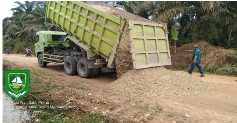
Gambar 3. 13 Penumpukan base B oleh Dump Truck
