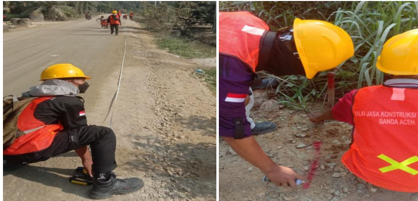
Gambar 3. 11 Pengukuran dan perletakan patok
