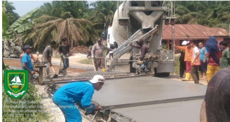
Gambar 3. 31 Pengecoran Rigid
