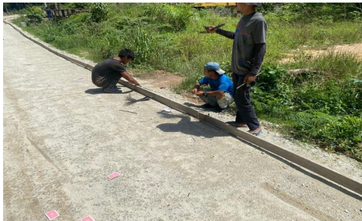
Gambar 3. 20 Pemasangan bekisting Lantai Kerja (LC)
