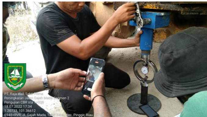
Gambar 3. 17 Pengujian CBR lapangan
