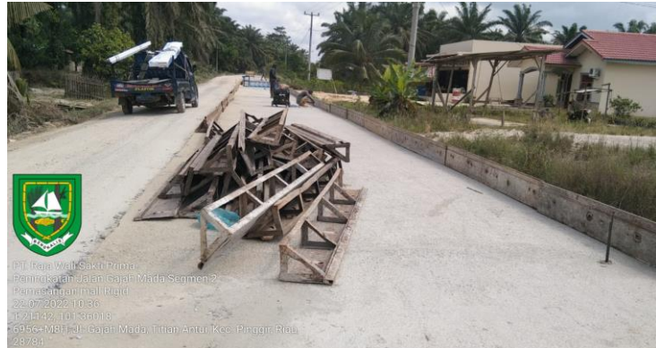
Gambar 3. 25 Pemasangan bekisting Rigid
