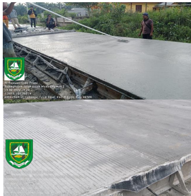
Gambar 3. 33 Pembuatan Alur Grooving
