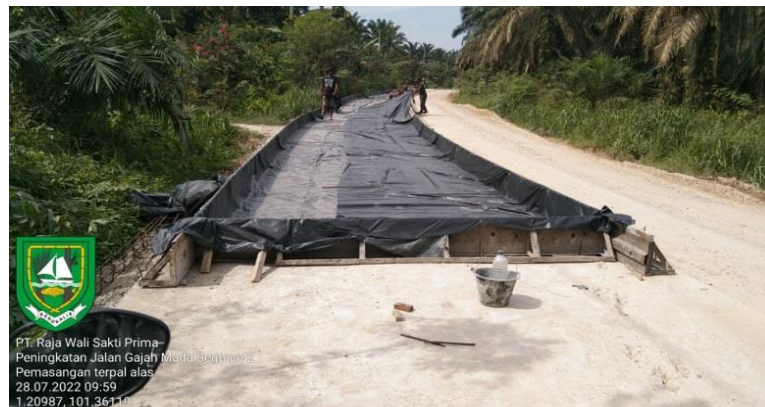
Gambar 3. 26 pemasangan pelastik sheet
