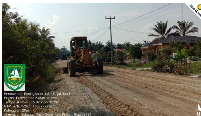
Gambar 3. 12 Penyiapan badan jalan
