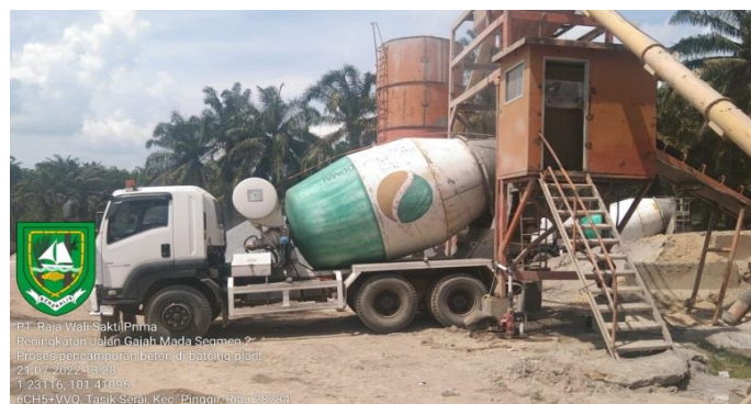
Gambar 3. 28 Pembuatan beton Ready mix
