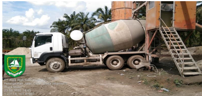
Gambar 3. 21 Pembuatan Beton Ready Mix
