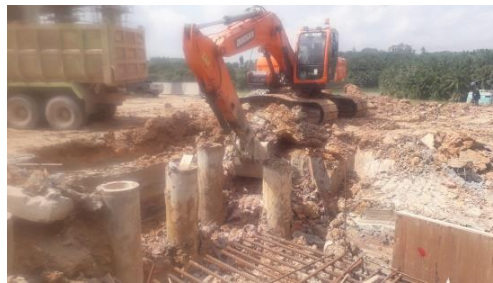
Gambar 3. 6 Pemindahan Tanah Kedalam Truck
