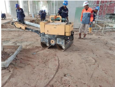
Gambar 3. 29 pemadatan Tanah
