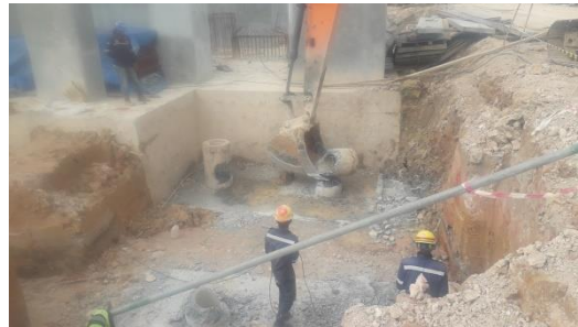
Gambar 3. 9 Pemotongan Spun Pile
