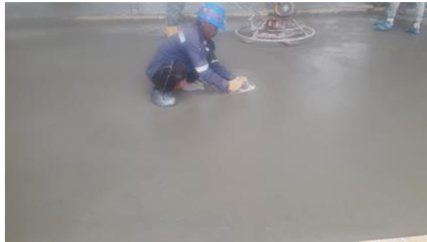
Gambar 3. 39 Penghalusan Menggunakan Raskam
