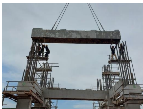
Gambar 3. 26 Penempatan Beam Pada Dowel
