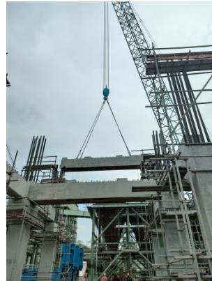
Gambar 3. 25 Pengangkatan Beam
