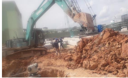
Gambar 3. 5 Penggalian Tanah Pile Cap
