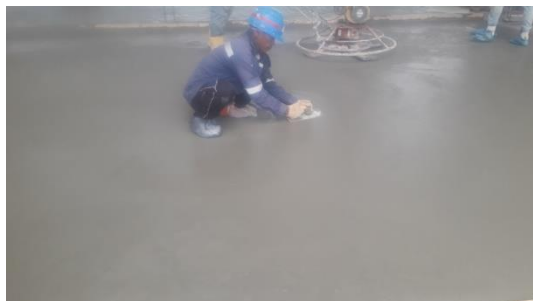
Gambar 3. 35 Penghalusan Menggunakan Raskam
