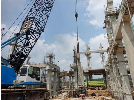
Gambar 3. 20 Pengangkatan Kolom
