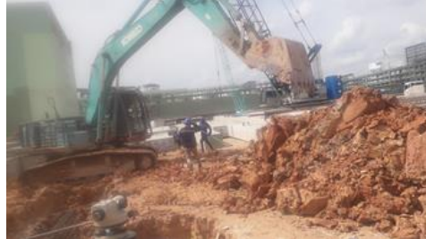
Gambar 3. 14 Penggalian Tanah Ground Beam
