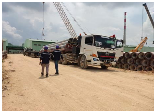
Gambar 3. 2 Pengangkatan Spun Pile
