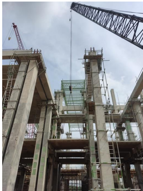
Gambar 3. 27 Pemasangan Slab Precast
