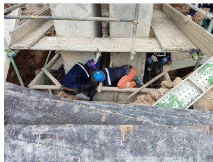
Gambar 3. 23 Pemasangan Bekisting
