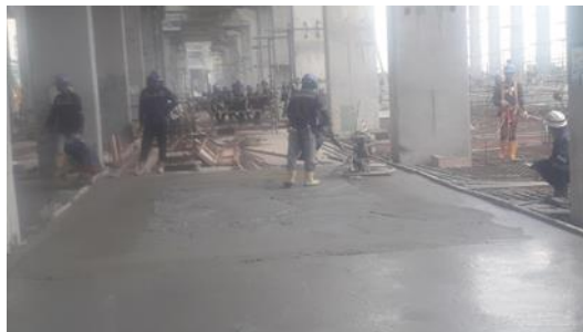
Gambar 3. 34 Meratakan Permukaan Beton Dengan Trowel
