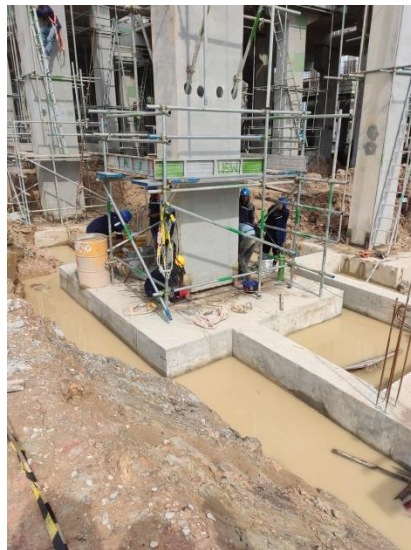
Gambar 3. 21 Pengelasan kolom dan Pile Cap
