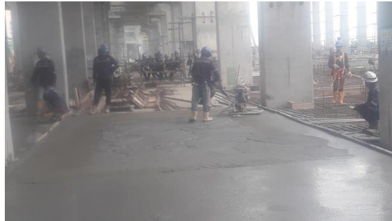
Gambar 3. 38 Meratakan Permukaan Beton Dengan Trowel
