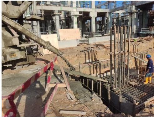
Gambar 3. 13 Pengecoran Pile Cap
