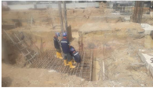
Gambar 3. 11 Pemasangan Dowel
