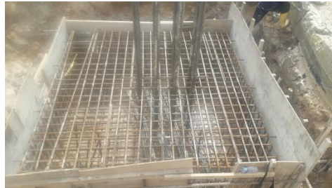
Gambar 3. 12 Pemasangan Bekisting
