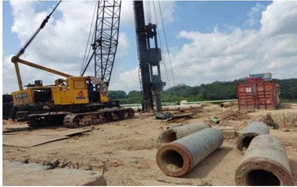
Gambar 3. 4 Pemancangan Spun Pile
