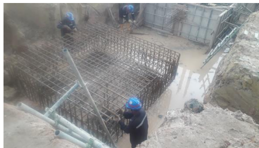
Gambar 3. 10 Pembesian Pile Cap
