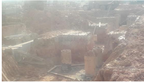
Gambar 3. 7 Pemasangan Bekisting
