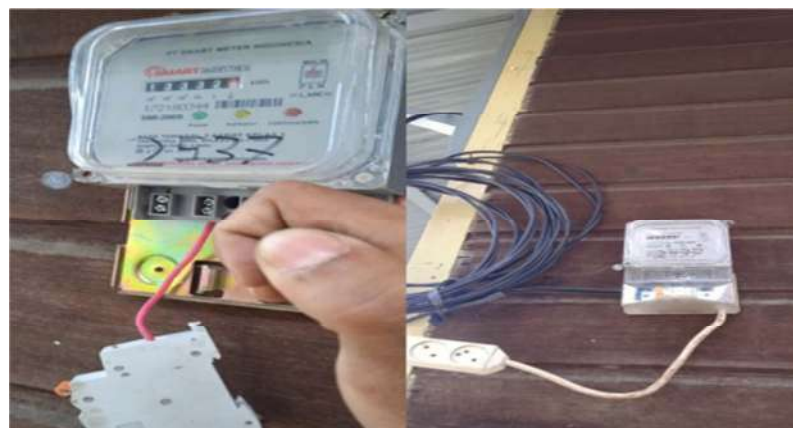
Gambar 2.33. Pemindahan Kwh Meter Sementara (Sumber:PT.PLN ULP Bagan Siapi-Api 2022)
