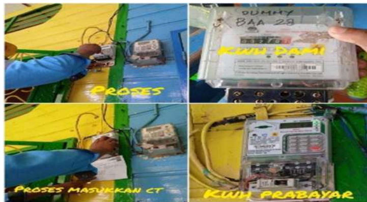
Gambar 2.57. Pemasangan baru Kwh meter prabayar (Sumber:PT.PLN ULP Bagan Siapi-Api 2022)
