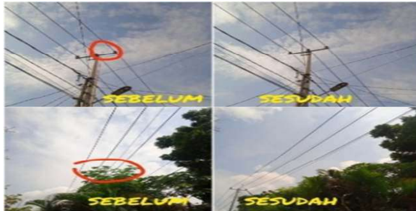
Gambar 2.45. Pemeliharaan JTM (jaringan tegangan menengah) (Sumber:PT.PLN ULP Bagan Siapi-Api 2022)
