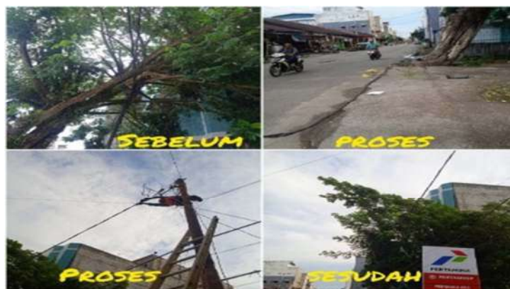
Gambar 2.58. Memperbaiki SKU-TR terimpa pohon (Sumber:PT.PLN ULP Bagan Siapi-Api 2022)
