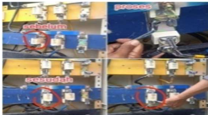
Gambar 2.44. Pergantian Ground Plat dan NH Fuse (Sumber:PT.PLN ULP Bagan Siapi-Api 2022)
