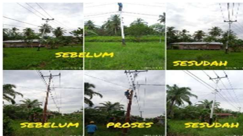
Gambar 2.48. Pengecatan Tiang dan pemasangan track schoor (Sumber: PT.PLN ULP Bagan Siapi-Api 2022)
