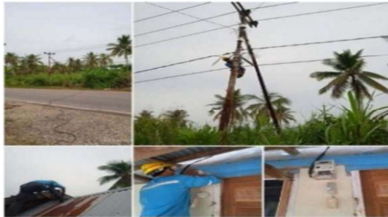
Gambar 2.37. Memperbaiki kabel SR putus (Sumber:PT.PLN ULP Bagan Siapi-Api 2022)
