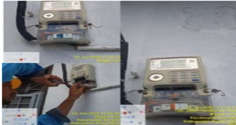
Gambar 2.17. Pergantian MCB baru (Sumber:PT.PLN ULP Bagan Siapi-Api 2022)
