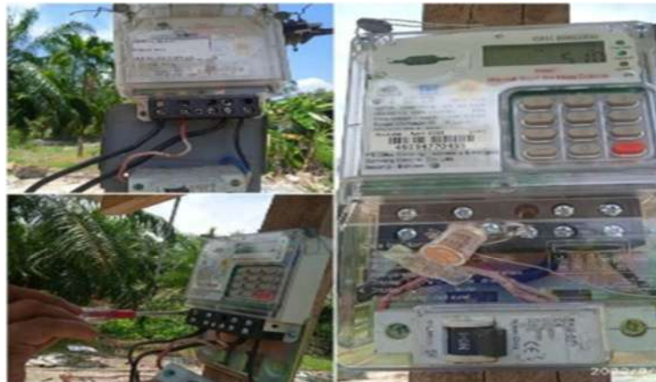
Gambar 2.55. Pemasangan Kwh meter prabayar (Sumber:PT.PLN ULP Bagan Siapi-Api 2022)
