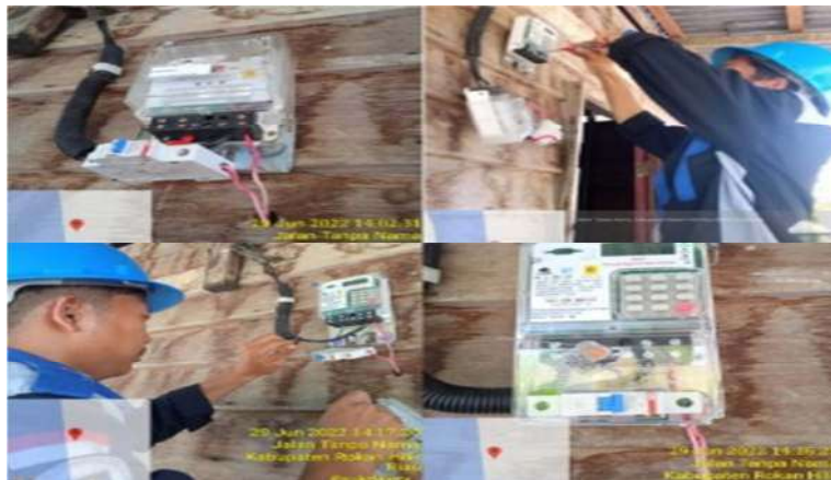
Gambar 2.22. Pemasangan kwh meter baru (Sumber:PT.PLN ULP Bagan Siapi-Api 2022)
