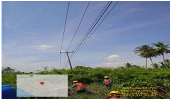
Gambar 2.4. Pemeliharaan JTM(Jaringan tegangan menengah) (Sumber:PT.PLN ULP Bagan Siapi-Api 2022)
