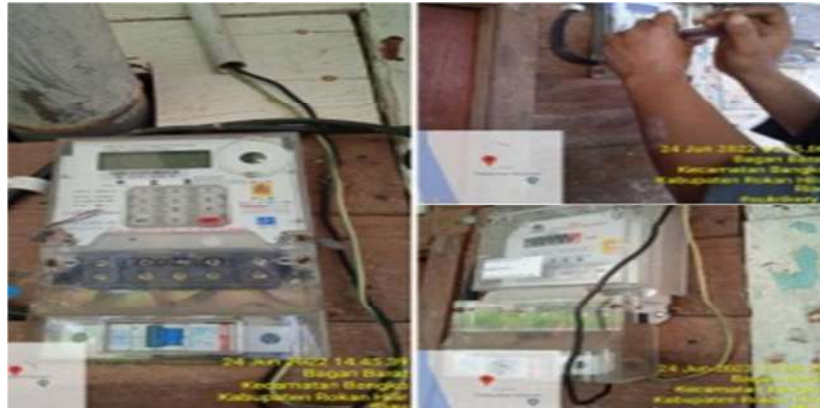
Gambar 2.19. Pergantian kwh meter sementara atau kwh meter dami (Sumber:PT.PLN ULP Bagan Siapi-Api 2022)
