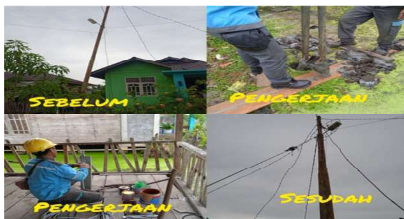
Gambar 2.26. Pemasangan Treck Schoor pada tiang (Sumber:PT.PLN ULP Bagan Siapi-Api 2022)
