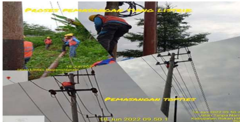
Gambar 2.14. Pemasangan Tiang listrik (Sumber:PT.PLN ULP Bagan Siapi-Api 2022)
