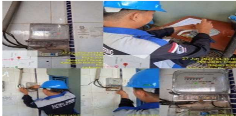
Gambar 2.20. Pemasangan kwh meter baru (Sumber:PT.PLN ULP Bagan Siapi-Api 2022)
