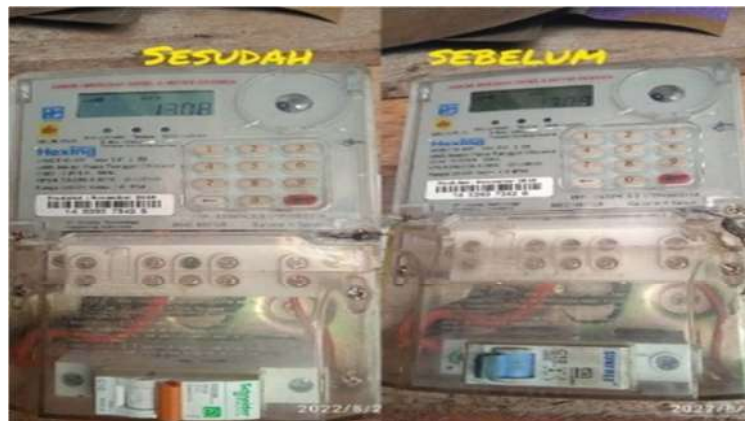
Gambar 2.60. Pergantian mcb Kwh meter prabayar (Sumber:PT.PLN ULP Bagan Siapi-Api 2022)
