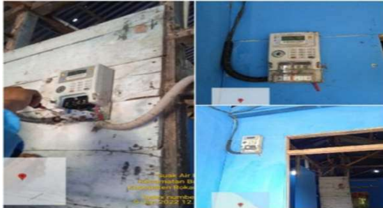
Gambar 2.7. Pemindahan kwh meter prabayar (Sumber:PT.PLN ULP Bagan Siapi-Api 2022)
