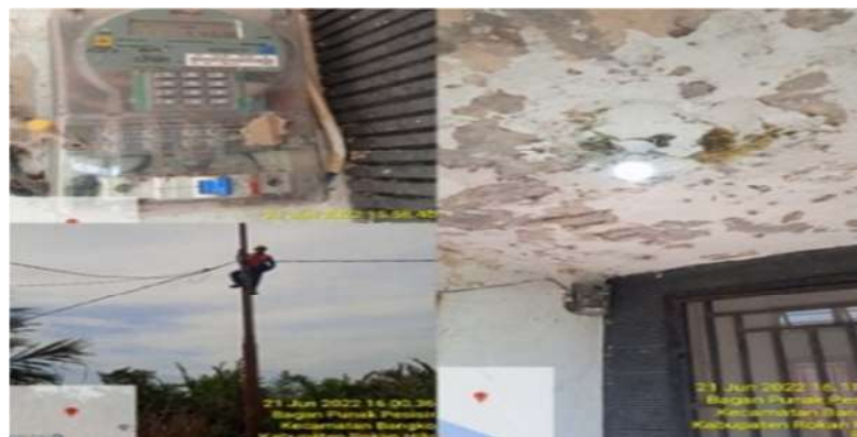
Gambar 2.16. Memperbaiki kabel SR (Sumber:PT.PLN ULP Bagan Siapi-Api 2022)
