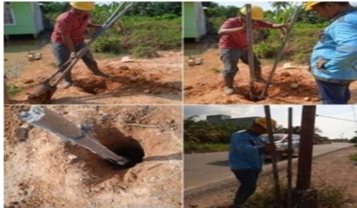
Gambar 2.34. Penggalian lubang untuk Tiang Listrik (Sumber:PT.PLN ULP Bagan Siapi-Api 2022)
