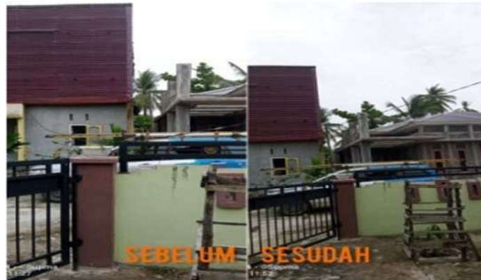
Gambar 2.64. Memperbaiki Kabel SR Kendor (Sumber:PT.PLN ULP Bagan Siapi-Api 2022)
