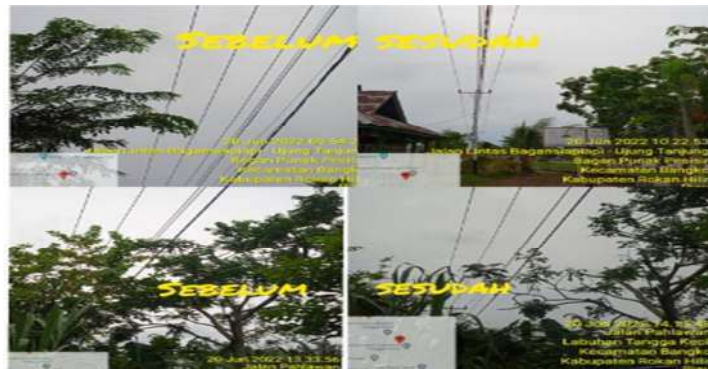
Gambar 2.15. Pemeliharaan JTM(jaringan tegangan menengah) (Sumber:PT.PLN ULP Bagan Siapi-Api 2022)
