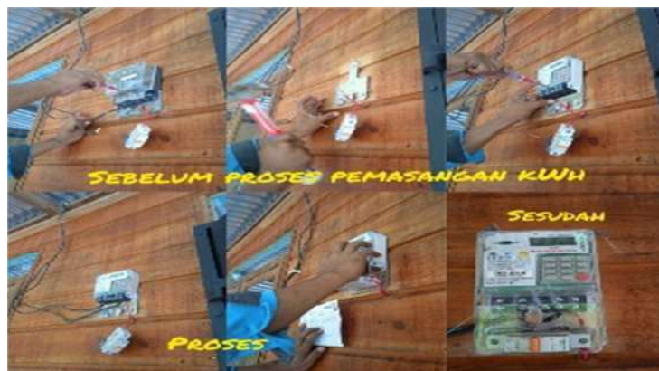
Gambar 2.63. Pergantian/pemasangan Kwh meter baru prabayar (Sumber:PT.PLN ULP Bagan Siapi-Api 2022)
