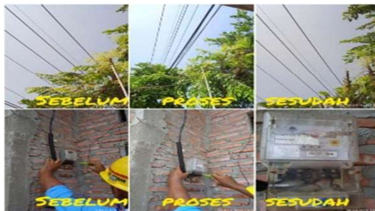
Gambar 2.51. Pemeliharaan JTM dan pemasangan Kwh dami/sementara (Sumber:PT.PLN ULP Bagan Siapi-Api 2022)
