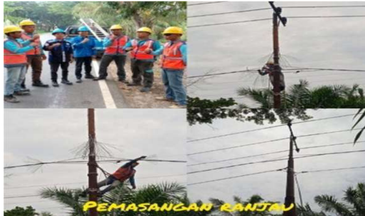
Gambar 2.27. Pemasangan kawat ranjau (Sumber:PT.PLN ULP Bagan Siapi-Api 2022)
