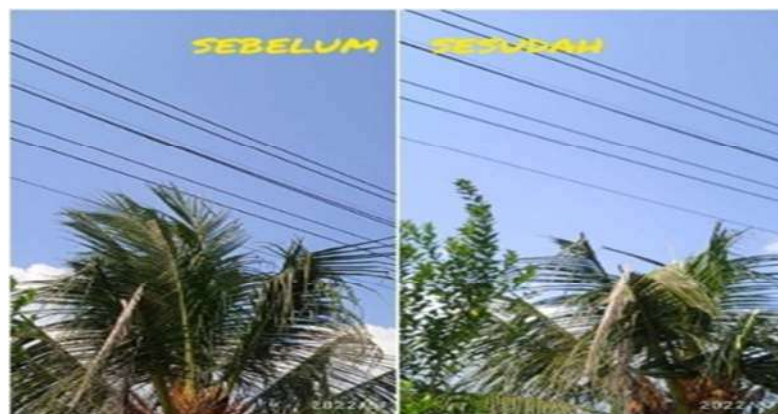
Gambar 2.53. Pemeliharaan JTM (jaringan tegangan menengah) (Sumber:PT.PLN ULP Bagan Siapi-Api 2022)
