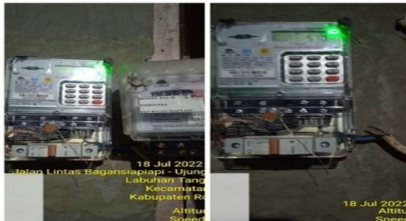
Gambar 2.35. Pemasangan Kwh meter baru (Sumber:PT.PLN ULP Bagan Siapi-Api 2022)
