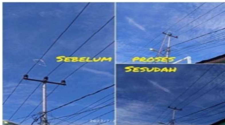
Gambar 2.41. Pemeliharaan JTM (jaringan tegangan menengah) (Sumber:PT.PLN ULP Bagan Siapi-Api 2022)
