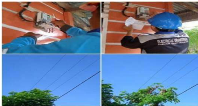
Gambar 2.12. Pemeliharaan JTM dan pemasangan kwh meter baru (Sumber:PT.PLN ULP Bagan Siapi-Api 2022)
