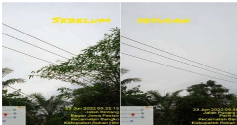
Gambar 2.18. Pemeliharaan JTM(jaringan tegangan menengah) (Sumber:PT.PLN ULP Bagan Siapi-Api 2022)
