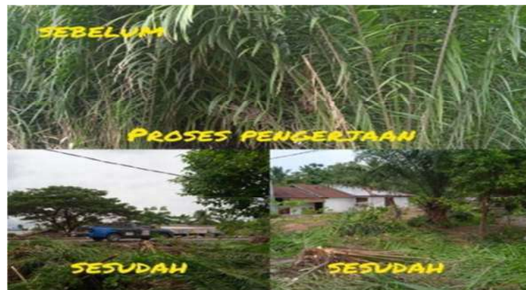
Gambar 2.31. Pemeliharaan JTM (jaringan tegangan menengah) (Sumber:PT.PLN ULP Bagan Siapi-Api 2022)
