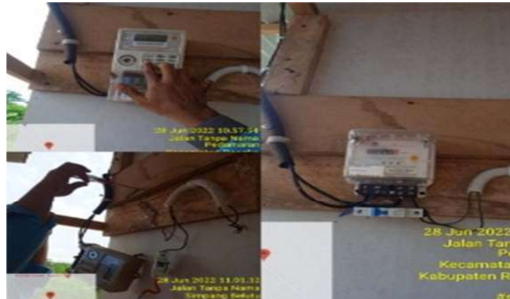
Gambar 2.21. Pergantian kwh meter sementara atau kwh meter dami (Sumber:PT.PLN ULP Bagan Siapi-Api 2022)
