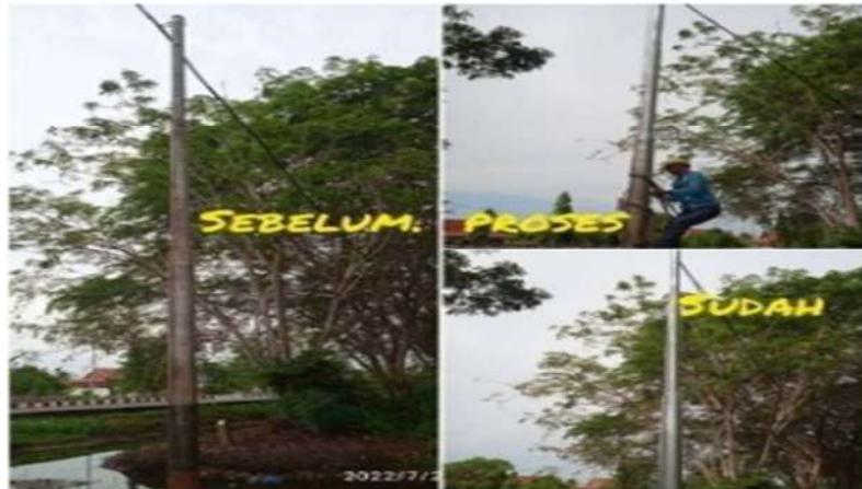
Gambar 2.42. Pengecatkan Tiang Listrik (Sumber:PT.PLN ULP Bagan Siapi-Api 2022)
