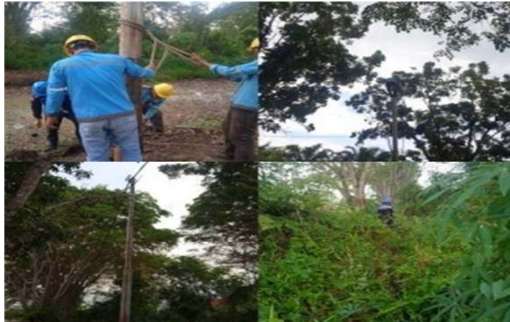
Gambar 2.39. Pemasangan kabel SKU-TR (Sumber:PT.PLN ULP Bagan Siapi-Api 2022)
