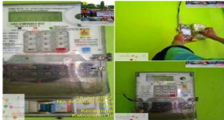
Gambar 2.40. Memasukan Clear Temper (Sumber:PT.PLN ULP Bagan Siapi-Api 2022)
