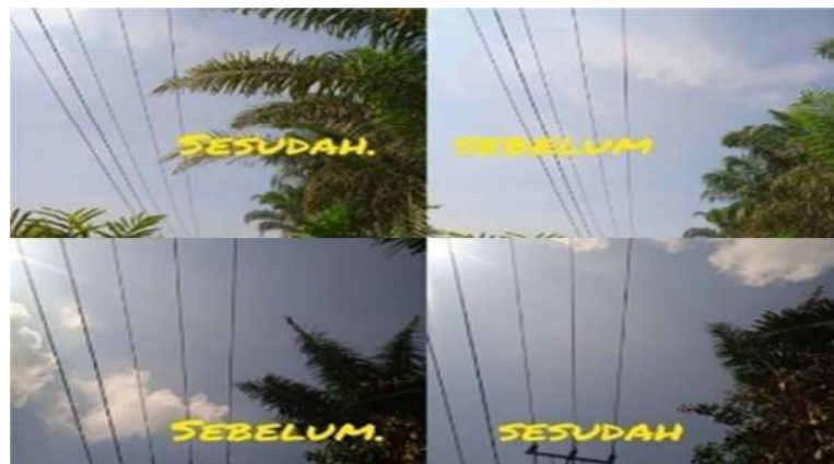
Gambar 2.38. Pemeliharaan JTM (jaringan tegangan menengah) (Sumber:PT.PLN ULP Bagan Siapi-Api 2022)
