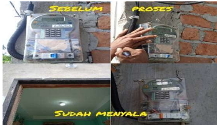
Gambar 2.62. Pergantian mcb Kwh meter prabayar (Sumber:PT.PLN ULP Bagan Siapi-Api 2022)
