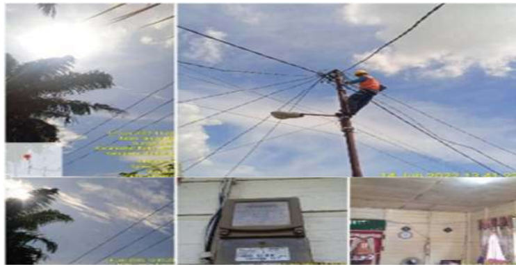
Gambar 2.10. Pemeliharaan JTM(jaringan tegangan menengah) (Sumber:PT.PLN ULP Bagan Siapi-Api 2022)
