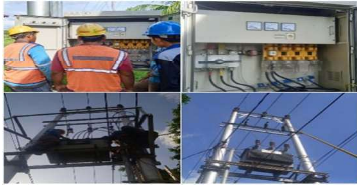
Gambar 2.1. Pemeliharaan PBH-TR(panel hubung bagi) (Sumber:PT.PLN ULP Bagan Siapi-Api 2022)
