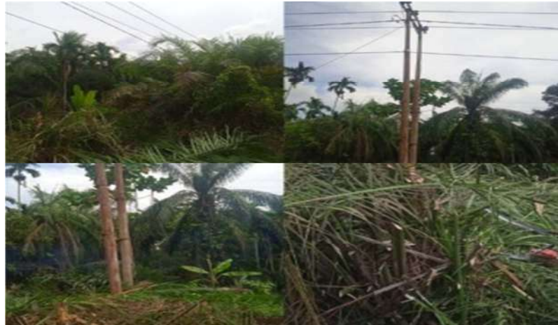
Gambar 2.30. Pemeliharaan JTM (jaringan tegangan menengah) (Sumber:PT.PLN ULP Bagan Siapi-Api 2022)
