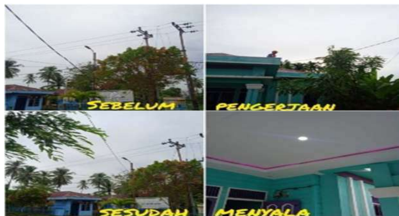
Gambar 2. 46. Memperbaiki Kabel SR putus (Sumber:PT.PLN ULP Bagan Siapi-Api 2022)
