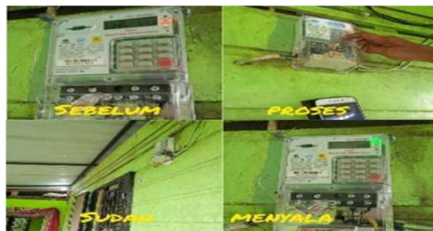
Gambar 2.61. Memasukan CT (CLEAR TAMPER) (Sumber:PT.PLN ULP Bagan Siapi-Api 2022)
