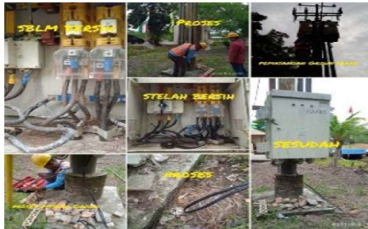
Gambar 2.47. Pemeliharaan PHB-TR (Sumber: PT.PLN ULP Bagan Siapi-Api 2022)
