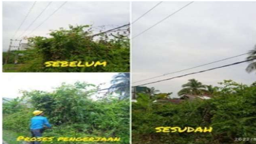
Gambar 2.49. Pemeliharaan JTM (jaringan tegangan menengah) (Sumber:PT.PLN ULP Bagan Siapi-Api 2022)
