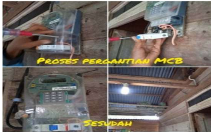
Gambar 2.59. Pergantian MCB Kwh meter Prabayar (Sumber:PT.PLN ULP Bagan Siapi-Api 2022)
