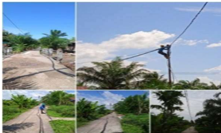
Gambar 2.43. Pemasangan kabel SKU-TR (Sumber:PT.PLN ULP Bagan Siapi-Api 2022)
