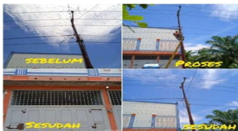
Gambar 2.56. Memperbaiki kabel SKU-TR putus (Sumber:PT.PLN ULP Bagan Siapi-Api 2022)
