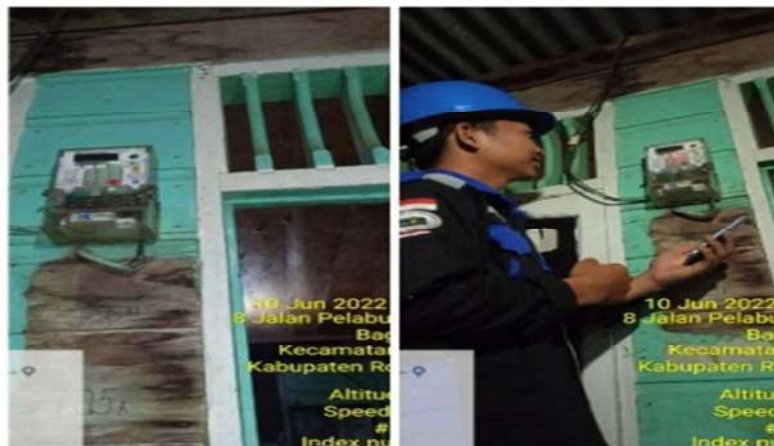
Gambar 2.8. memasukan nomor CT pada kwh prabayar (Sumber:PT.PLN ULP Bagan Siapi-Api 2022)
