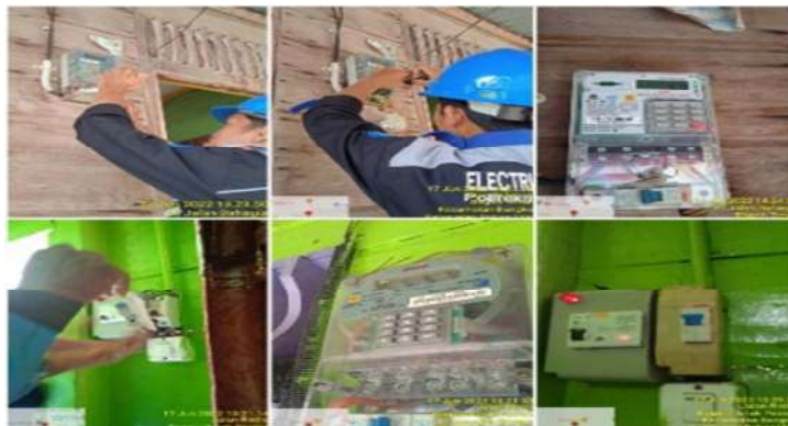
Gambar 2.13. pergantian kwh meter baru dan mcb baru (Sumber:PT.PLN ULP Bagan Siapi-Api 2022)
