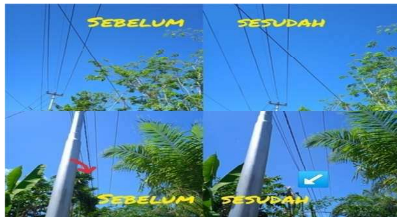
Gambar 2.25. Pemeliharaan JTM(jaringan tegangan menengah) (Sumber:PT.PLN ULP Bagan Siapi-Api 2022)
