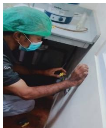
Gambar 2. 14 : perbaikan kran bocor
