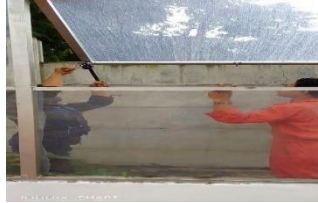
Gambar 2. 25: pemasangan jendela Sumber : Dokumentasi pribadi di PT.Cassia Co-op.
