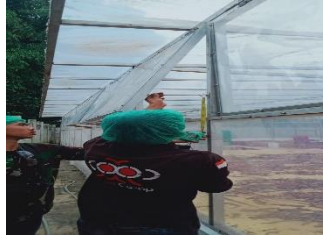
Gambar 2. 23: pengukuran jendela Sumber : Dokumentasi pribadi di PT.Cassia Co-op.
