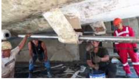
Gambar 2.48 Pemasangan Shaft Propeller
