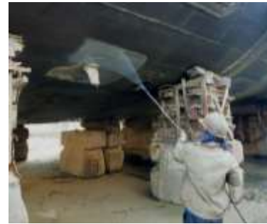
Gambar 3.8 Proses pengecatan
