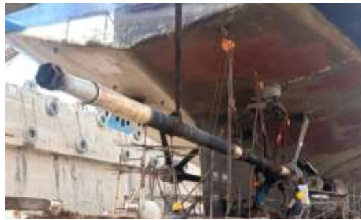
Gambar 2.42 Pemasangan Shaft Propeller
