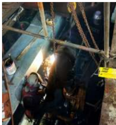
Gambar 2.12 Pemasangan Pipa Cerobong
