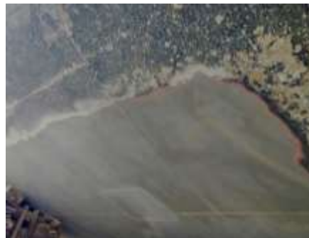
Gambar 3.3 Perbedaan sebelum dan sesudah disandblast
