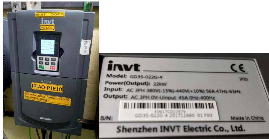
Gambar 3.8 VSD dan Nameplate GCC Pump PT. IKPP (Sumber: Dokumentasi di PT. Indah Kiat Pulp & Paper)
