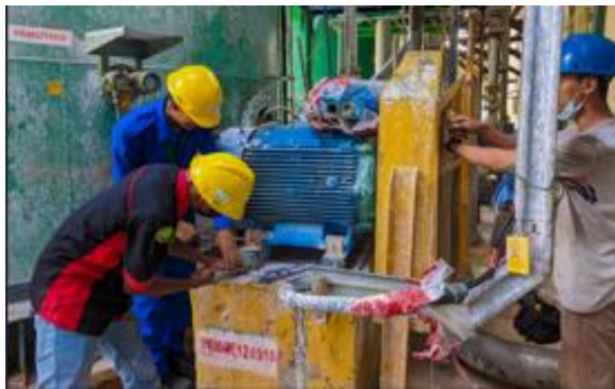
Gambar 2.11 Pembongkaran Motor Yang Terbakar (Sumber: Dokumentasi di PT. Indah Kiat Pulp & Paper)
