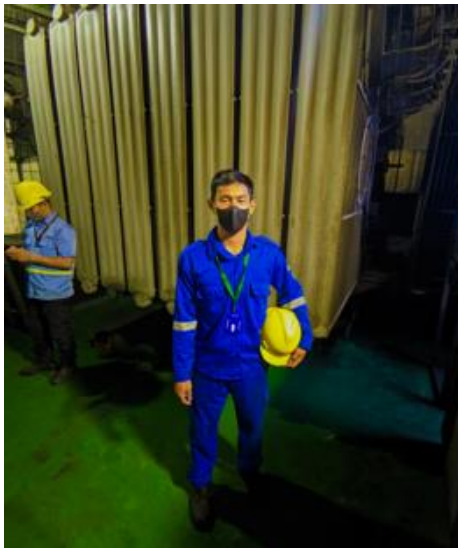
Gambar 2.4 Pembersihan Trafo Step Down 33 Kv (Sumber: Dokumentasi di PT. Indah Kiat Pulp & Paper)
