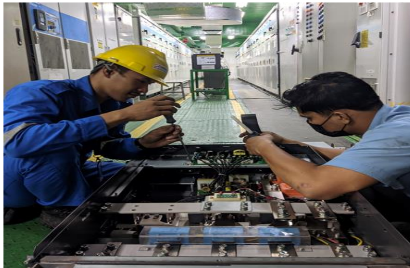
Gambar 2.1 Pembersihan Komponen Inverter Ex Dryer 5 (Sumber: Dokumentasi di PT. Indah Kiat Pulp & Paper)
