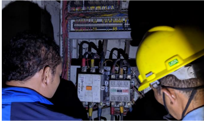
Gambar 2.15 Penggantian MCCB Timbangan Rasau Kuning (Sumber: Dokumentasi di PT. Indah Kiat Pulp & Paper)
