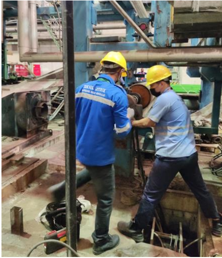
Gambar 2.3 Pembongkaran Kabel Motor di OMC (Sumber: Dokumentasi di PT. Indah Kiat Pulp & Paper)
