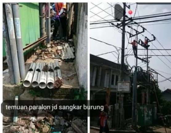
Gambar 3.14 Gangguan akibat sarang burung Sumber: https://qurthobi.staff.telkomuniversity.ac.id
