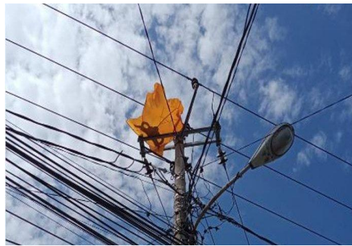
Gambar 3.13 Gangguan akibat layang-layang Sumber: https://qurthobi.staff.telkomuniversity.ac.id
