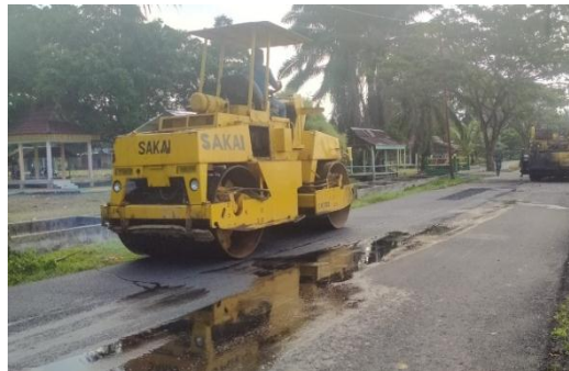
Gambar 4.3 Tandem Roller (Sumber : Dokumentasi Lapangan,2021 )
