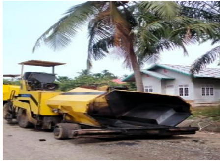
Gambar 3.6 Asphalt Finisher (Sumber : Dokumentasi Lapangan, 2021 )
