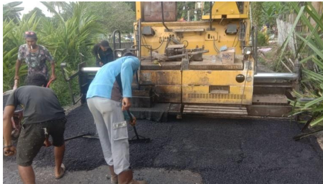
Gambar 3.10 Pekerjaan Penghamparan Aspal (Sumber : Dokumentasi Lapangan, 2021)
