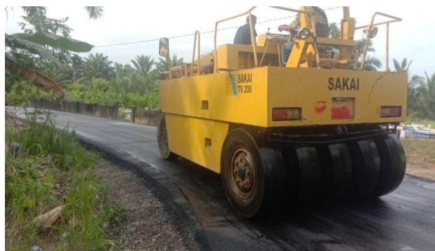
Gambar 4.9 Pemasangan dengan menggunakan pneumatic tyre roller (Sumber : Dokumentasi Lapangan,2021)
