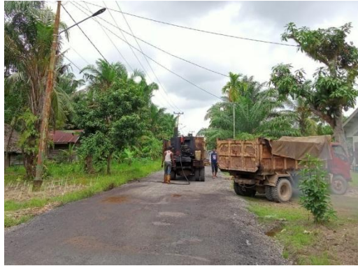
Gambar 3.9 Penyemprotan prime coat (Sumber : Dokumentasi Lapangan,2021)
