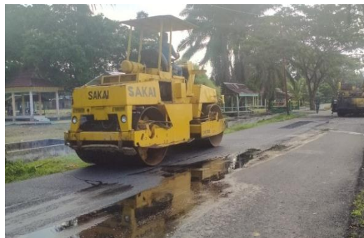
Gambar 4.8 Pemasatan menggunakan tandem roller (Sumber : Dokumentasi Lapangan,2021)
