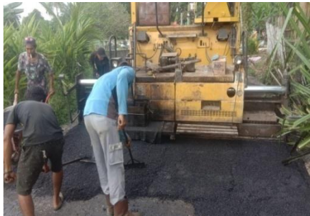
Gambar 4.6 Penghamparan aspal (Sumber : Dokumentasi Lapangan,2021)
