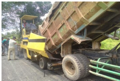
Gambar 4.5 Penghamparan aspal ke asphalt finisher (Sumber : Dokumentasi Lapangan, 2021)
