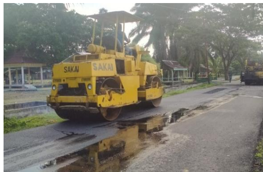
Gambar 3.11 Pemadatan Aspal Menggunakan Tandem Roller (Sumber : Dokumentasi Lapangan, 2021)
