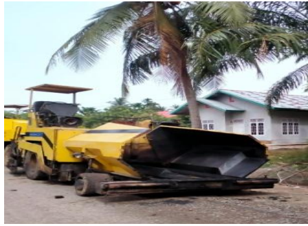
Gambar 4.2 Asphalt Finisher (Sumber : Dokumentasi Lapangan,2021 )
