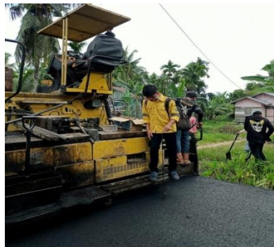
Gambar 4.7 Pengecekan tebal gembur dengan stik (Sumber : Dokumentasi Lapangan, 2021)
