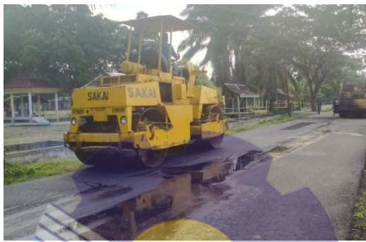
Gambar 4.8 Pemasatan menggunakan tandem roller (Sumber : Dokumentasi Lapangan, 2021)
