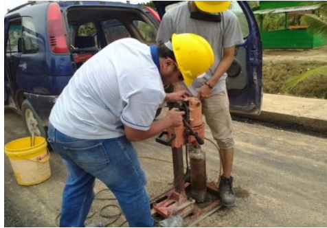
Gambar 3.13 Pekerjaan Core Drill Asphalt (Sumber : dokumentasi Lapangan,2021)
