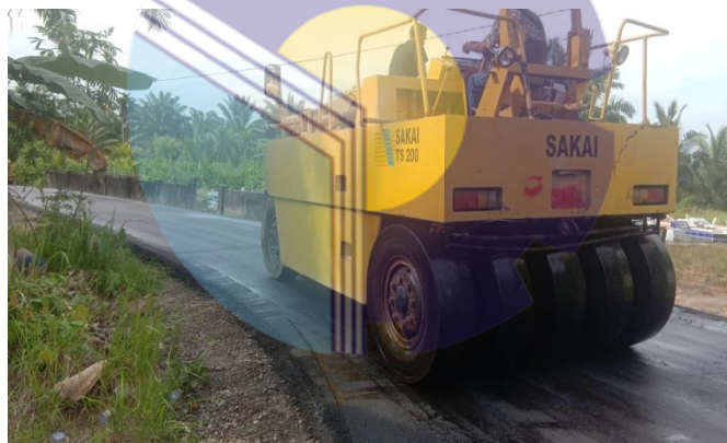
Gambar 3.11 Pemadatan menggunakan Pneumatic tyre roller (Sumber : Dokumentasi Lapangan,2021)
