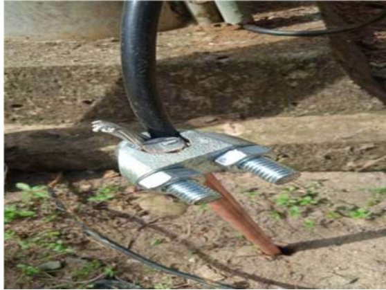
Gambar 2.3 Pemasangan Grounding
