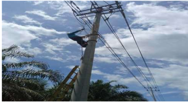
Gambar 2.9 Pemasangan Kawat Urai
