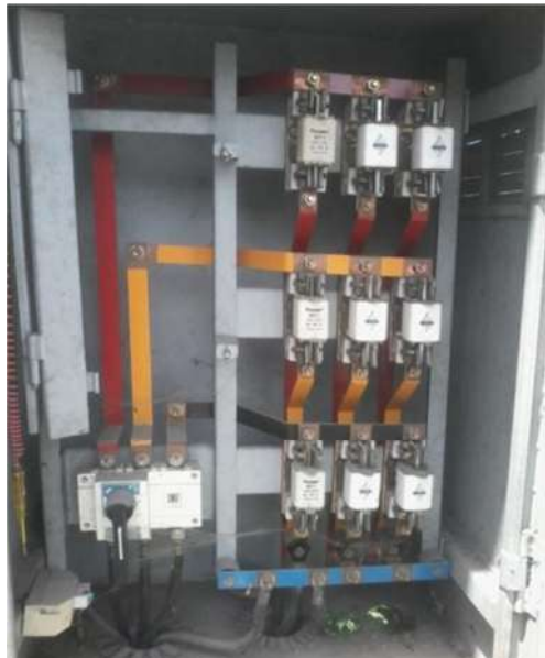
Gambar 3.5 Rangkaian Dalam Gardu
