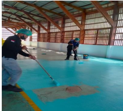
Gambar 2.40: Pengecatan lantai gedung material (Sumber :Dokumentasi 2022)
