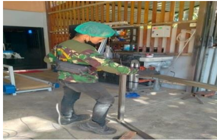
Gambar2.26:Pembuatan Kerangka Jendela (Sumber :Dokumentasi 2022)
