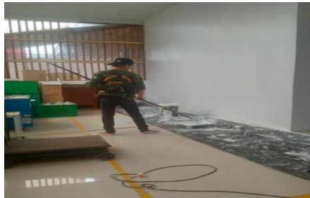
Gambar 2.42: Pengecatan dinding ruang flasing (Sumber :Dokumentasi 2022)
