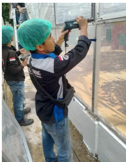
Gambar2.30: pemasangan jendela (Sumber :Dokumentasi 2022)
