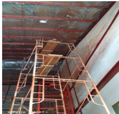
Gambar 2.34: Pemasangan lampu di gedung grinding (Sumber :Dokumentasi 2022)
