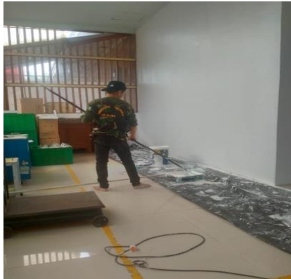
Gambar 2.45: Pengecatan dinding ruang flasing (Sumber :Dokumentasi 2022)
