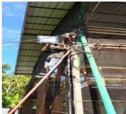
Gambar2.23:Pemasangan Lapu Sorot (Sumber :Dokumentasi 2022)
