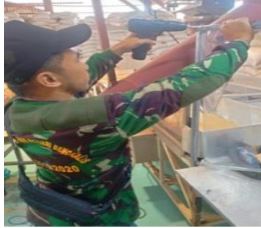
Gambar 2.11.Pemasanan Tirai Penutup Debu (Sumber :Dokumentasi 2022)
