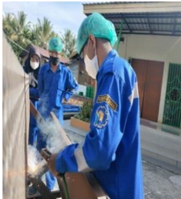
Gambar 2.1 perbaikan Tangga Loding (Sumber: Dokumentasi 2022)
