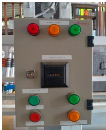
Gambar 3.3. Panel (Mesin Jahit Otomatis) Sumber : Dokumentasi Pribadi di PT. Cassia Co-op
