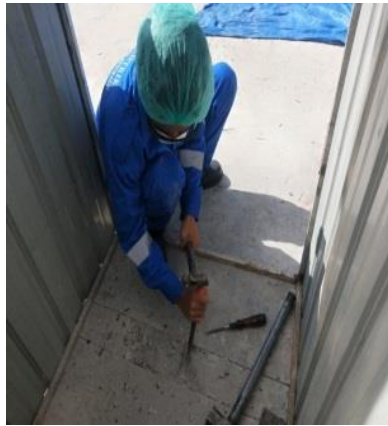
Gambar 2.2 :Pembobokan Beton Untuk Tempat Pemasangan Rel Pintu (sumber:dokumentasi 2022)
