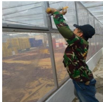
Gambar 2.28: Pemasangan Jendela Draying Hose (Sumber :Dokumentasi 2022)
