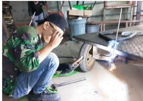
Gambar 2.12: Pengelasan Grobak Blending (Sumber :Dokumentasi 2022)
