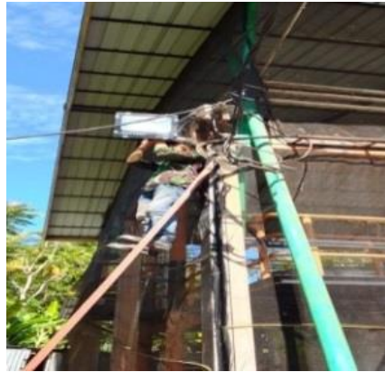
Gambar2.16:Pemasangan Lapu Sorot (Sumber :Dokumentasi 2022)
