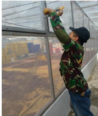
Gambar2.29: Pemasangan Jendela Drying Hose (Sumber :Dokumentasi 2022)
