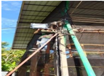
Gambar2.21:Pemasangan Lapu Sorot (Sumber :Dokumentasi 2022)
