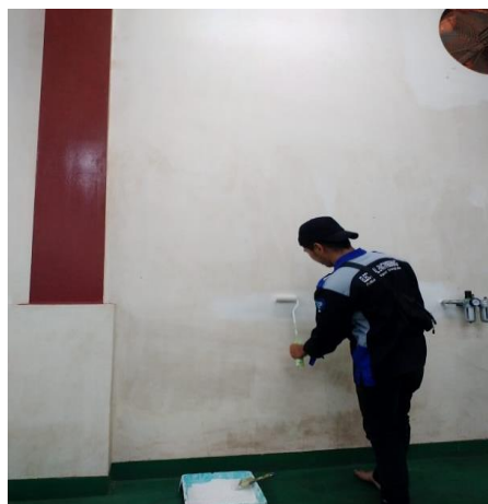
Gambar 2.51: Pengecatan dinding gedung grinding (Sumber :Dokumentasi 2022)
