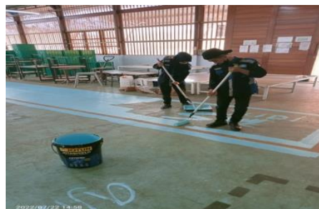
Gambar 2.38: Pengecatan lantai gedung stick (Sumber :Dokumentasi 2022)
