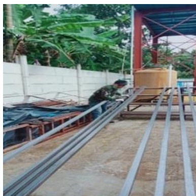
Gambar 2.9.:Pengecatan Besi hollow (Sumber :Dokumentasi 2022)
