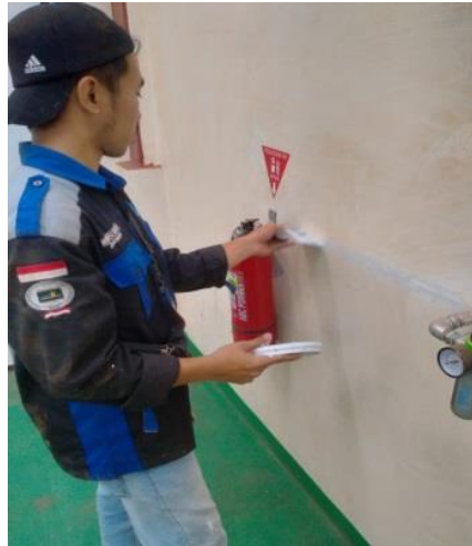
Gambar 2.50: Mendempul dinding retak (Sumber :Dokumentasi 2022)
