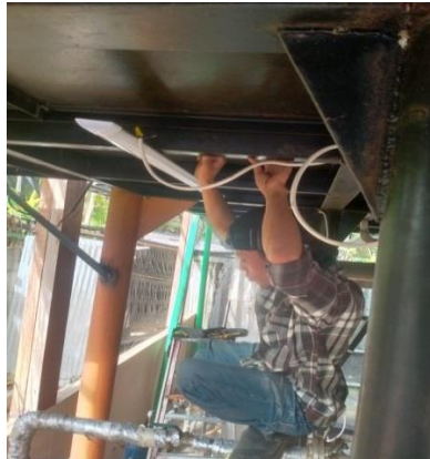
Gambar 2.32: Pemasangan Lampu Di Distilasi (Sumber :Dokumentasi 2022)
