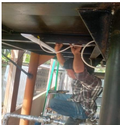
Gambar 2.33: Pemasangan Lampu Di Distilasi (Sumber :Dokumentasi 2022)
