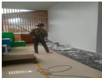
Gambar 2.43: Pengecatan dinding ruang flasing (Sumber :Dokumentasi 2022)
