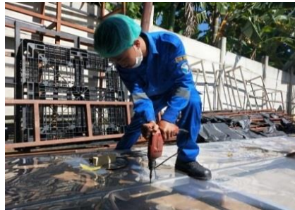
Gambar 2.4: Pemasangan Flexilon Pada Kerangka Pintu (Sumber :Dokumentasi 2022)
