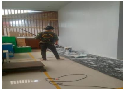
Gambar 2.44: Pengecatan dinding ruang flasing (Sumber :Dokumentasi 2022)
