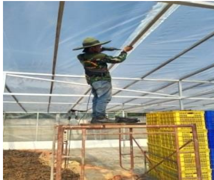
Gambar2.19:penggantian atap dan prabung UV (Sumber :Dokumentasi 2022)
