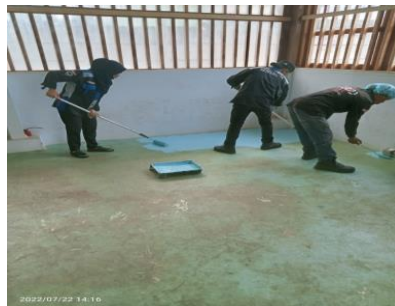
Gambar 2.37: Pengecatan lantai gedung stick (Sumber :Dokumentasi 2022)
