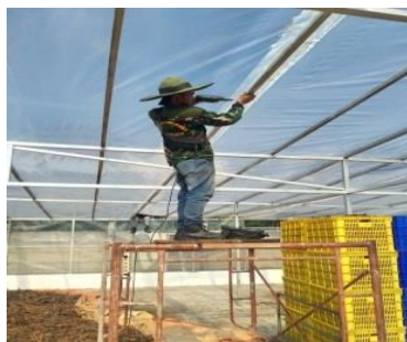
Gambar2.14:penggantian atap UV (Sumber :Dokumentasi 2022)
