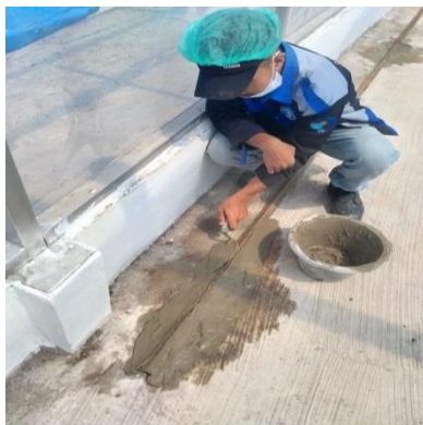
Gambar 2.3:Pemasangan Rel Pintu (Sumber:Dokumentasi 2022)
