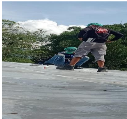
Gambar 2.15: Pemasangan Prabung Atap UV (Sumber :Dokumentasi 2022)
