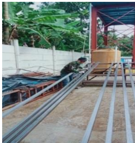
Gambar 2.7.: Pengecatan Besi hollow (Sumber :Dokumentasi 2022)
