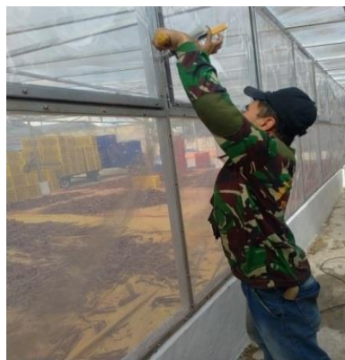
Gambar2.31: Pemasangan Pengunci Jendela (Sumber :Dokumentasi 2022)
