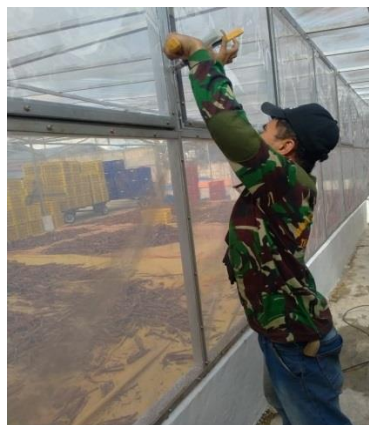
Gambar 2.36: Pemasangan Togkat Jendela Draying House (Sumber :Dokumentasi 2022)
