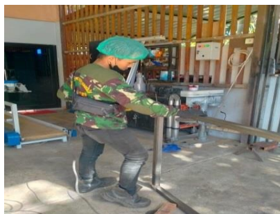
Gambar2.25:Pembuatan Kerangka Jendela (Sumber :Dokumentasi 2022)
