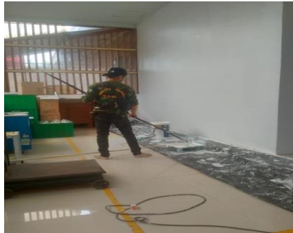
Gambar 2.47: Pengecatan dinding ruang flasing (Sumber :Dokumentasi 2022)
