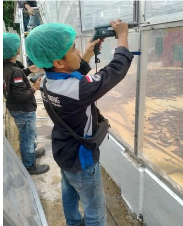
Gambar 2.35: Pemasangan Togkat Jendela Draying House (Sumber :Dokumentasi 2022)
