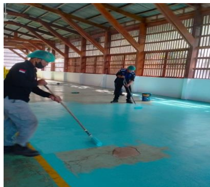
Gambar 2.41: Pengecatan lantai gedung material (Sumber :Dokumentasi 2022)
