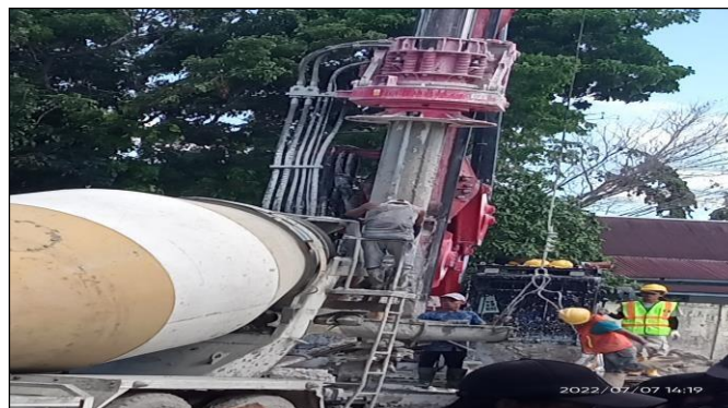
Gambar 3.17 Proses pengecoran dengan menggunakan alat mekanis (Sumber : Dokumentasi lapangan 2022)
