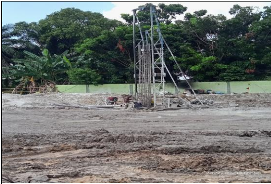
Gambar 3.3 Dokumentasi proses pemasukan besi bored pile secara manual (sumber : dokumentasi lapangan 2022)
