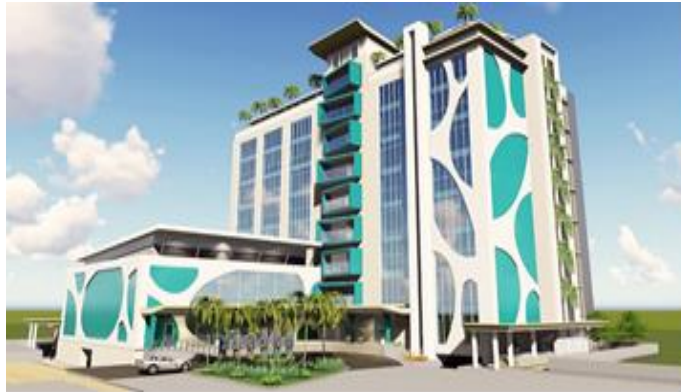
Gambar 1.1 Proyek Pembangunan Gedung Perkuliahan Poltekes Kemenkes Riau
