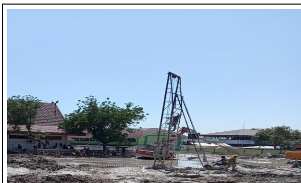
Gambar 3.7 Proses pengeboran menggunakan alat manual
