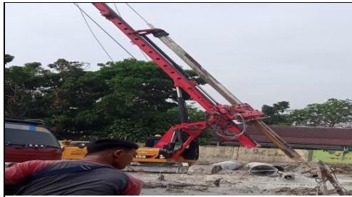
Gambar 3.25 Drilling Rig (Sumber : Dokumentasi lapangan, 2022)
