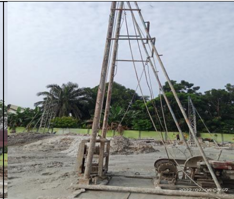
Gambar 3.6 Alat Bored Pile Gawangan (sumber : dokumentasi lapangan 2022)
