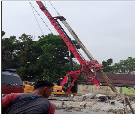
Gambar 3.5 Alat Bored Pile Drilling Rig (sumber : dokumentasi lapangan 2022)
