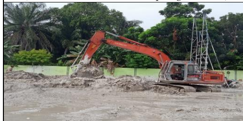
Gambar 3.21 Excavator (Sumber: Dokumentasi lapangan 2022)
