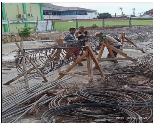
Gambar 3.8 Proses perakitan besi tulangan D19 (Sumber ; Dokumentasi Lapangan 2022)
