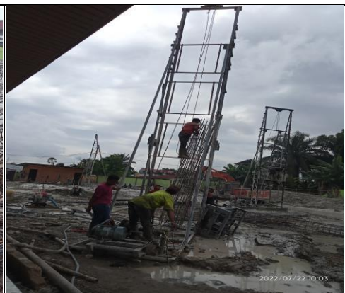
Gambar 3.9 Proses pemasukan besi tulangan (Sumber :Dokumentasi Lapangan 2022)
