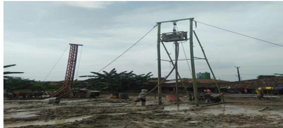
Gambar 3.12 Mini crane gawangan (Sumber: Dokumentasi lapangan)
