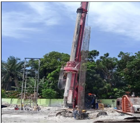
Gambar 3.15 Proses pemasukan tulangan menggunakan alat mekanis (sumber : dokumentasi Lapangan 2022)
