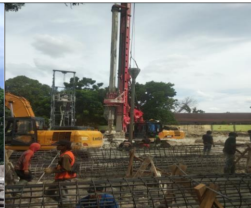
Gambar 3.16 Proses pemasukan Pipa Tremie dengan menggunakan alat mekanis (sumber : dokumentasi Lapangan 2022)
