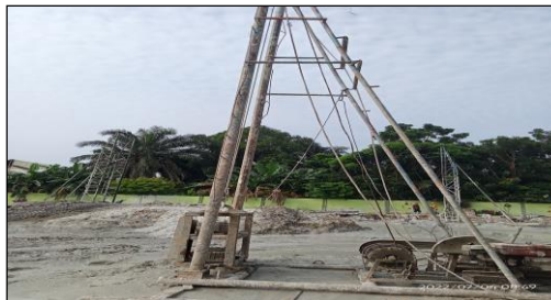
Gambar 3.26 Mini crane gawangan Sumber Dokumentasi lapangan 2022
