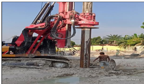
Gambar 3.13 Proses pengeboran menggunakan alat mekanis
