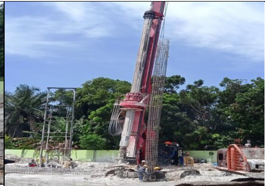
Gambar 3.4 Dokumentasi proses pemasukan besi bored pile secara mekanis (sumber : dokumentasi 2022)
