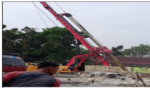
Gambar 3.18 Mini crane (Sumber:Dokumentasi lapangan 2022)
