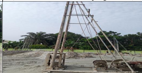
Gambar 3.22 Mini crane gawangan (Sumber: Dokumentasi lapangan 2022)
