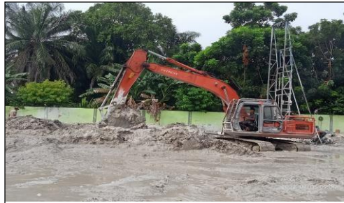
Gambar 3.23 Excavator (Sumber : Dokumentasi lapangan, 2022)
