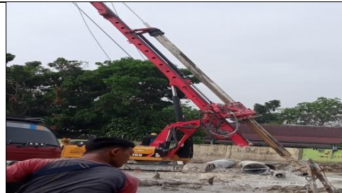
Gambar 3.20 Mini crane (Sumber: Dokumentasi lapangan 2022)
