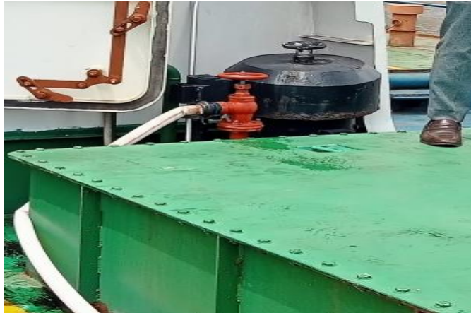
Gambar 2.6 Pengelasan pada hydrant kapal
