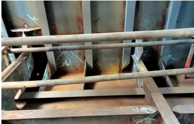
Gambar 2.35 Pemeriksaan hasil pengelasan bracke
