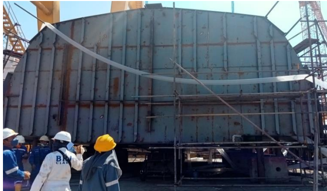
Gambar 2.32 Bangunan baru pada bagian mesin
