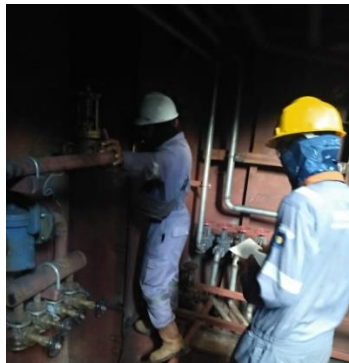
2.18 Pemeriksaan bagian-bagian pipe dikapal Tugboat
