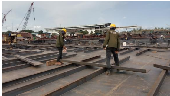
Gambar 2.14 Inspect angle trans.bhd typical frame pada Hull No.1451
