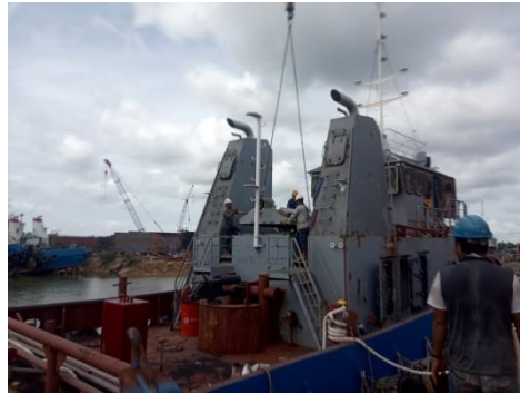
Gambar 3.9 Pengangkatan engine casing oleh crawler crane
