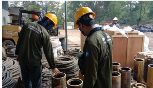
Gambar 2.27 Memeriksa cabl e yang cocok untuk pompa
