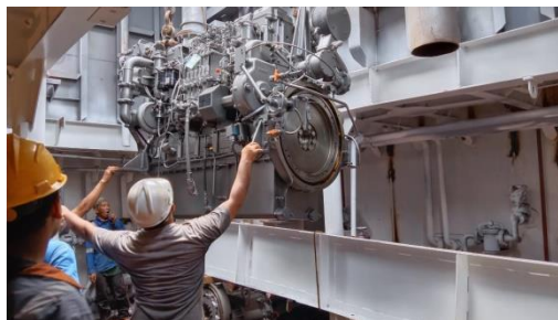
Gambar 2.36 Peletakan dan pemasangan Main Engine
