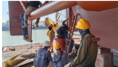
Gambar 2.54 Mengikuti pemasangan propeller
