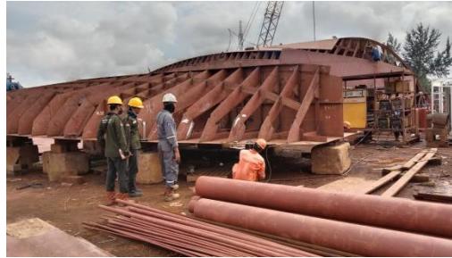
Gambar 2.28 Proses pemasangan Pipe Penetration
