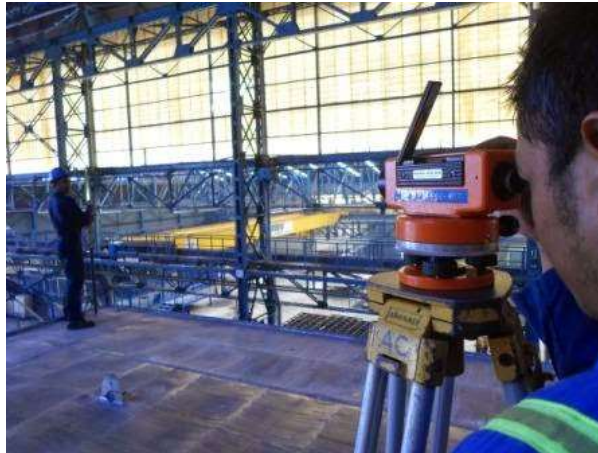
Gambar 3.10 Pengukuran ketinggian deck
