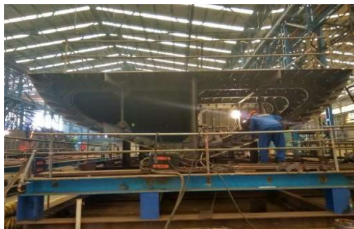
Gambar 3.11 Proses pengecekan deformasi
