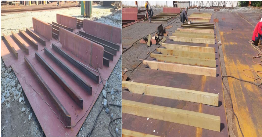
Gambar 3.2 Proses Pemasangan Stiffener
