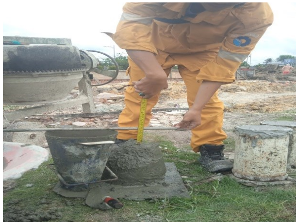
Gambar 3. 4 Slump Test Sumber : Dokumentasi 2022
