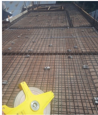
Gambar 3. 1 Survey lapangan Perhitungan Volume kebutuhan Sumber : Dokumentasi 2022
