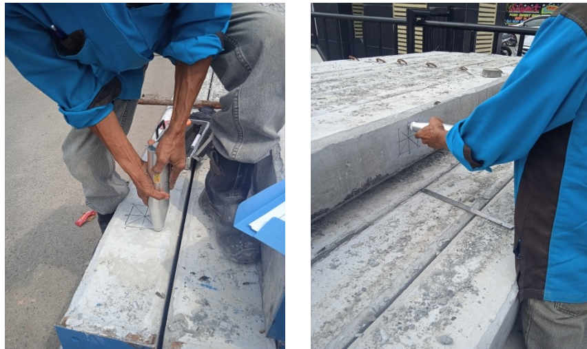
Gambar 3. 8 Hammer Test Tiang Pancang Sumber : Dokumentasi 2022
