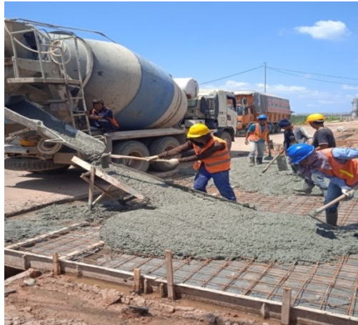
Gambar 3. 6 Pengawasan Pekerjaan Pengecoran
