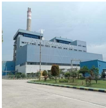
Gambar 1. 1. Penampakan PT PJB UBJOM PLTU Tenayan (sumber:Dokumentasi di PT PJB UBJOM PLTU Tenayan)
