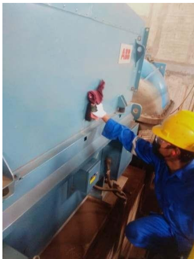
Gambar 317 Pembersihan Frame Motor (Sumber:Dokumentasi di PLTU Tenayan)
