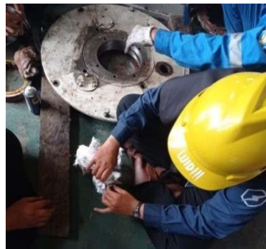
Gambar 2.47. Cleaning Pada Bearing Motor HPFF 6 Kv (Sumber: Dokumentasi di PT PJB UBJOM PLTU Tenayan)
