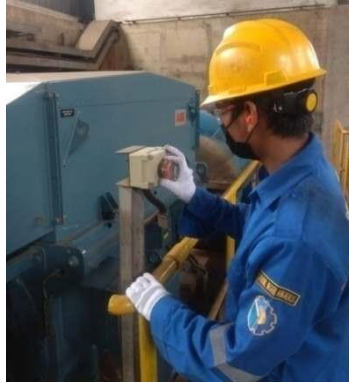
Gambar 3.22 Pengecekan Push button Off (Emergency) (Sumber:Dokumentasi di PLTU Tenayan)
