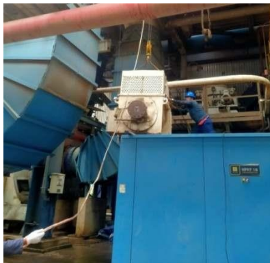
Gambar 2.43. Pemindahan Kedudukan Motor HPFF 6 Kv (Sumber: Dokumentasi di PT PJB UBJOM PLTU Tenayan)
