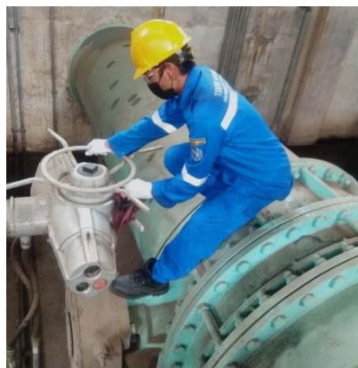
Gambar 3.23 Pengecekan MOV (Sumber:Dokumentasi di PLTU Tenayan)
