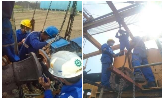
Gambar 2.42. Proses Pemasangan Motor Belt star up 380V Diarea Ship Unloading (Sumber: Dokumentasi di PT PJB UBJOM PLTU Tenayan)
