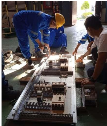
Gambar 2.39. Proses Perakitan Komponen-Komponen Didalam Panel Heater (Sumber: Dokumentasi di PT PJB UBJOM PLTU Tenayan)
