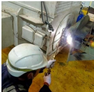
Gambar 2.45. Proses Pemuaian/Pemanasan Pada Kopling Motor HPFF 6 Kv (Sumber: Dokumentasi di PT PJB UBJOM PLTU Tenayan)
