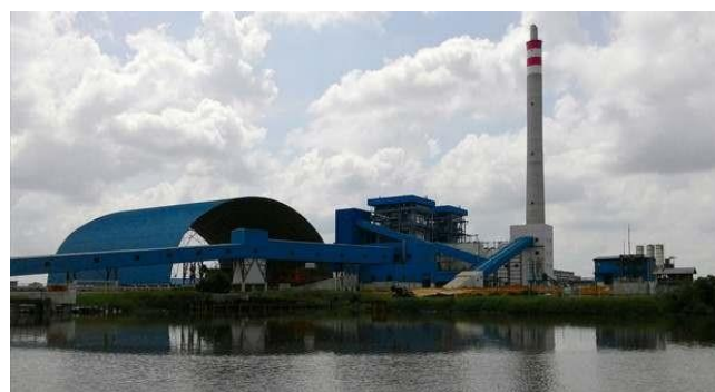
Gambar 1.3. PT PJB UBJOM PLTU Tenayan Dari Belakang (Sumber: PT PJB UMBJOM PLTU Tenayan)
