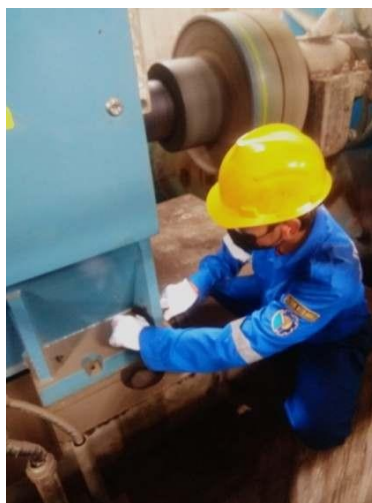
Gambar 3.15 Pemeriksaan Baut Pondasi (Sumber:Dokumentasi di PLTU Tenayan)
