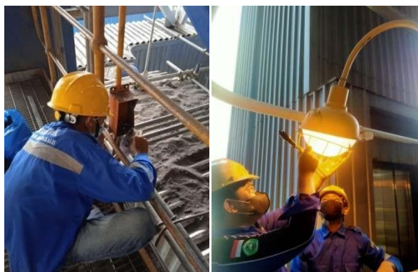
Gambar 2.49. Pemasangan Ballast Lampu Diarea Boiler (Sumber: Dokumentasi di PT PJB UBJOM PLTU Tenayan)
