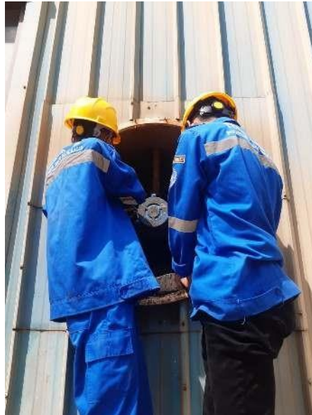
Gambar 2.38. Pemasangan Motor Exhaust fan 380V Diarea Luar CWP House (Sumber: Dokumentasi di PT PJB UBJOM PLTU Tenayan)
