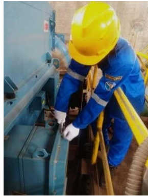
Gambar 3.18 Pemeriksaan Seal Box Terminasi (Sumber:Dokumentasi di PLTU Tenayan)
