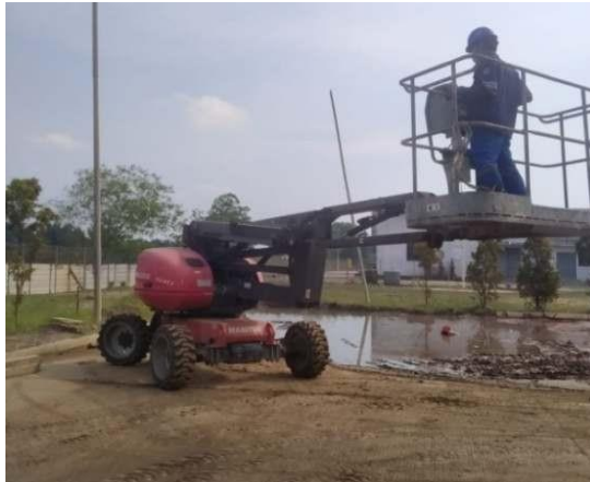
Gambar 2.48. Pemasangan Lampu Jalan 250W Diarea fly ash (Sumber: Dokumentasi di PT PJB UBJOM PLTU Tenayan)
