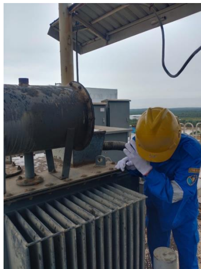
Gambar 3.19. Pemeriksaan Kelainan Suara Pada Trafo
