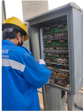
Gambar 3.21. Pemeriksaan Dan Pembersihan Panel Top Rapping (Sumber: Dokumentasi di PLTU Tenayan)
