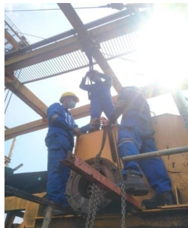
Gambar 2.42. Proses Pemasangan Motor Belt star up 380V Diarea Ship Unloading (Sumber: Dokumentasi di PT PJB UBJOM PLTU Tenayan)
