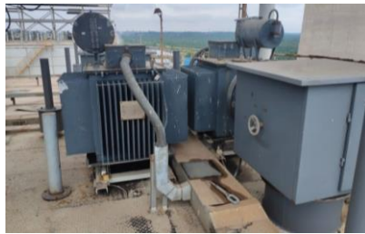
Gambar 3.15. Trafo ESP
