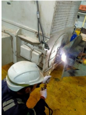
Gambar 2.45. Proses Pemuaian/Pemanasan Pada Copling Motor HPFF 6 Kv (Sumber: Dokumentasi di PT PJB UBJOM PLTU Tenayan)
