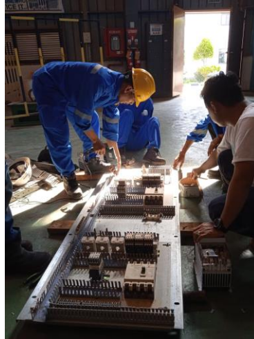
Gambar 2.39. Proses Perakitan Komponen-Komponen Didalam Panel Heater (Sumber: Dokumentasi di PT PJB UBJOM PLTU Tenayan)
