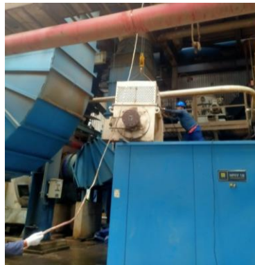
Gambar 2.43. Pemindahan Kedudukan Motor HPFF 6 Kv (Sumber: Dokumentasi di PT PJB UBJOM PLTU Tenayan)
