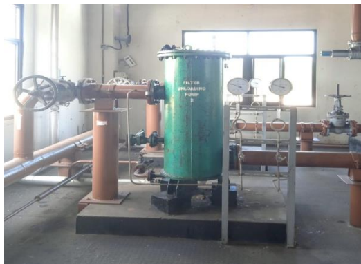
Gambar 2.31. Unloading Pump Filter Dua PLTU Tenayan (Sumber: Dokumentasi di PT PJB UBJOM PLTU Tenayan)
