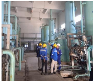
Gambar 2.18. Tanki Filtrasi
