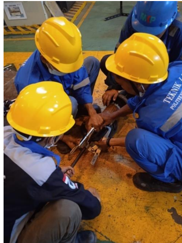
Gambar 2.41. Penggantian Bearing Pada Motor 380 V (Sumber: Dokumentasi di PT PJB UBJOM PLTU Tenayan)
