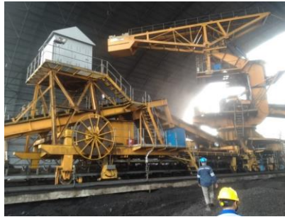
Gambar 2.25. Stacker Reclamator (Sumber: Dokumentasi di PT PJB UBJOM PLTU Tenayan)
