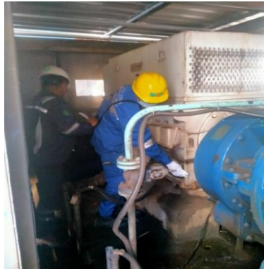
Gambar 2.37. PM Diarea Boiler Motor HPFF Unit Satu (Sumber: Dokumentasi di PT PJB UBJOM LTU Tenayan)
