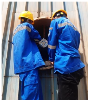
Gambar 2.38. Pemasangan Motor Exhaust fan 380V Diarea Luar CWP House (Sumber: Dokumentasi di PT PJB UBJOM PLTU Tenayan)
