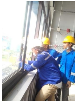
Gambar 2.7. Penjelasan Tentang Main Transformator Dari Ruangan Generator (Sumber: Dokumentasi di PT PJB UBJOM PLTU Tenayan)
