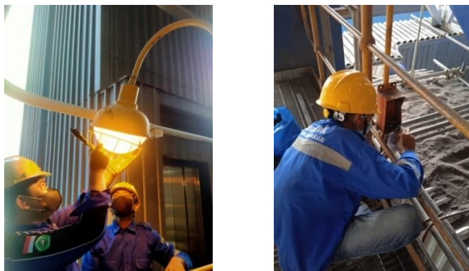
Gambar 2.49. Pemasangan Ballast Lampu Diarea Boiler (Sumber: Dokumentasi di PT PJB UBJOM PLTU Tenayan)
