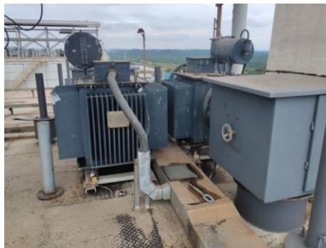
Gambar 3.12. Transformator Rectifier
