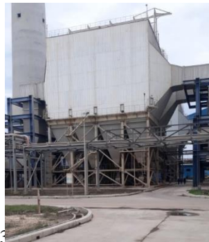
Gambar 3.1. Electrostatic Precipitator (EPS) (Sumber: Dokumentasi di PT PJB UBJOM PLTU Tenayan)
