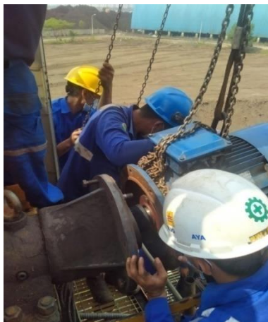
Gambar 2.42. Proses Pemasangan Motor Belt star up 380V Diarea Ship Unloading (Sumber: Dokumentasi di PT PJB UBJOM PLTU Tenayan)
