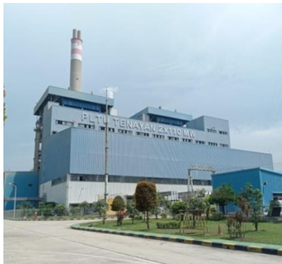
Gambar 1.1. Penampakan PT. PJB UBJOM PLTU Tenayan (sumber: Dokumentasi di PT. PJB UBJOM PLTU Tenayan)
