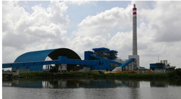
Gambar 1.3. PT. PJB UBJOM PLTU Tenayan Dari Belakang (Sumber: PT. PJB UMBJOM PLTU Tenayan)
