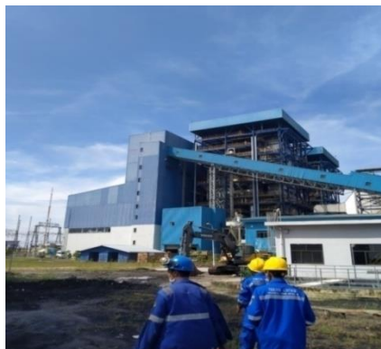
Gambar 1.2. Salah Satu Bagian PT. PJB UBJOM PLTU Tenayan (Sumber: Dokumentasi di PT. PJB UBJOM PLTU Tenayan)
