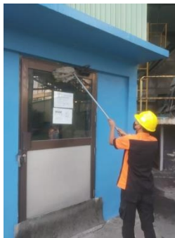
Gambar 2.9 Membersihkan ruangan cems analyzer (Sumber: Dokumentasi PT. Indah Kiat Pulp & Paper Tbk Perawang, 2022)
