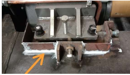
Gambar 2.37 Pemasangan kompon pada cetakan Chock Fast
