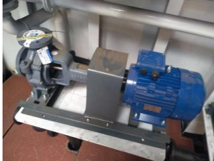
Gambar 3.4 Pompa Bilga-Ballast
