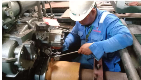
Gambar 2.29 Pengencangan baut pada gear box dan shaft proprller
