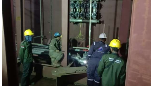
Gambar 2. 21 Routing line pada kapal Crane Barge
