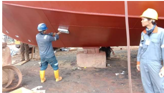
Gambar 2.46 Pemasangan Zinc Anode
