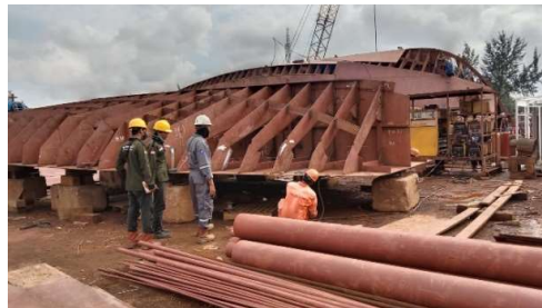
Gambar 2.26 Pemasangan Doubler
