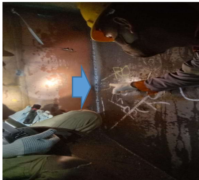
Gambar 2.15 Melihat kebocoran pengelasan dengan Air test bagian after peak tank
