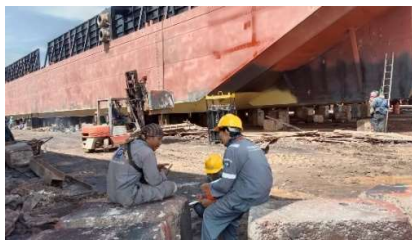
Gambar 2.59 Penjelasan mengenai cat chiller dan bahan suatu cat
