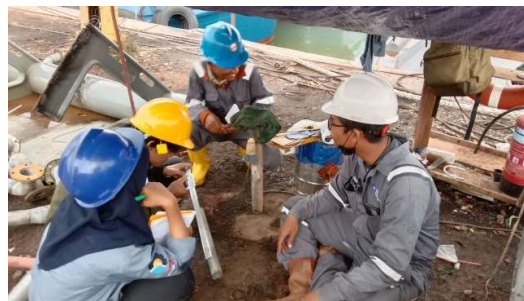
Gambar 2.61 Pengukuran pipa dengan alat Caliper
