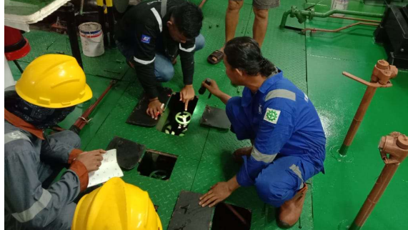
Gambar 2.19 Commissioning pada system pipa
