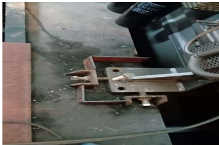
Gambar 2.33 Pembuatan cetakan chocfast pada dudukan/kaki Main Engine
