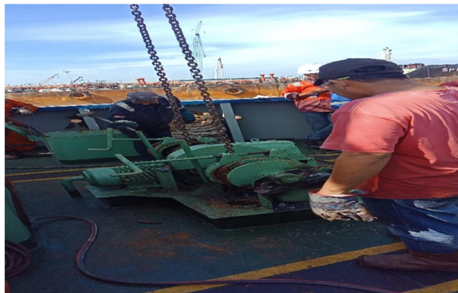
Gambar 2.15 : proses pengangkatan mesin jangkar/ anchor machine
