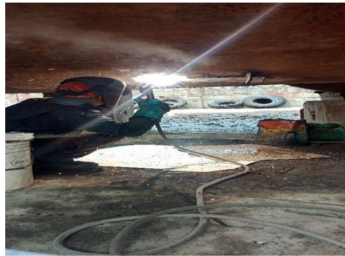
Gambar 2.17 : Proses reperasi pada kulit kapal
