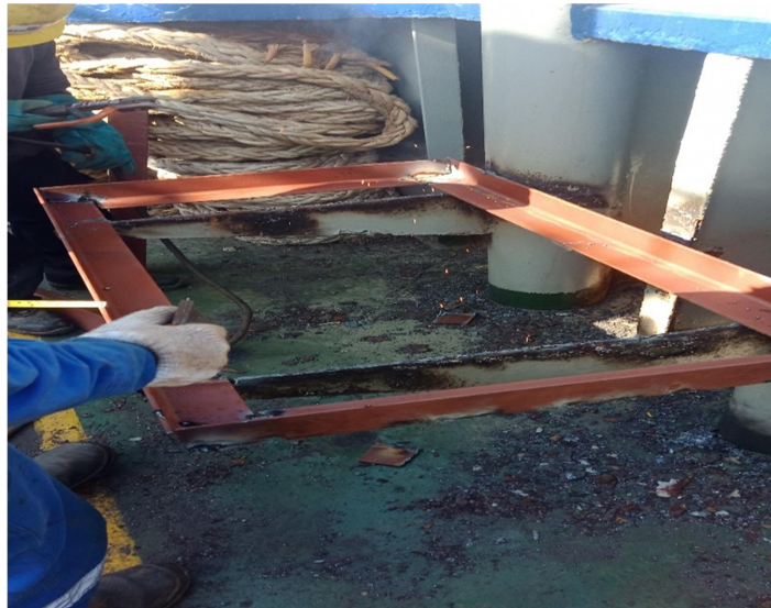
Gambar 2.16 ;Proses Reparasi Kedudukan untuk tali tambat pada Haluan
