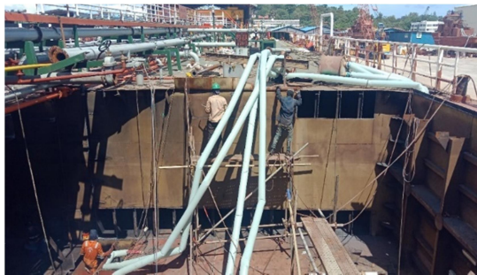
Gambar 2.30 ; Proses Reparasi bagian tangki, lantai dan pipa bawah
