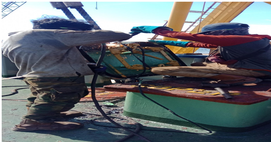
Gambar 2.13 : proses reparasi pada emergency exit
