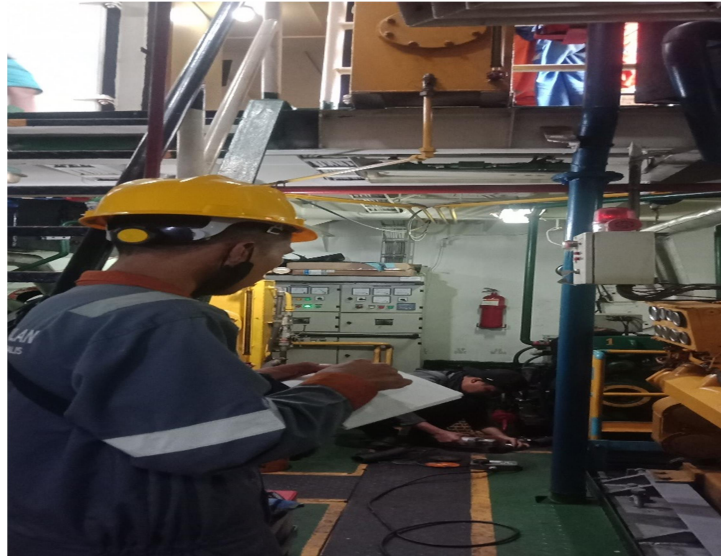
Gambar 3.1 : proses inspeksi pendingin mesin pada ruang engine
