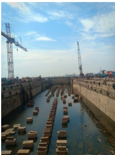
Gambar 3.12 Susunan bantalan KRI AHP -355
