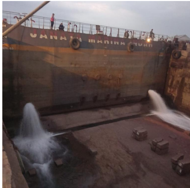
Gambar 3.18 Pengeluaran air ballast dari ponton ke dock
