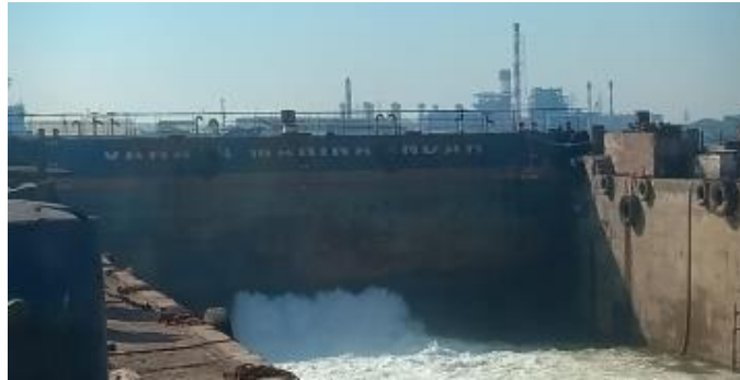
Gambar. 3.19 Pemasukan air laut ke kolam dock
