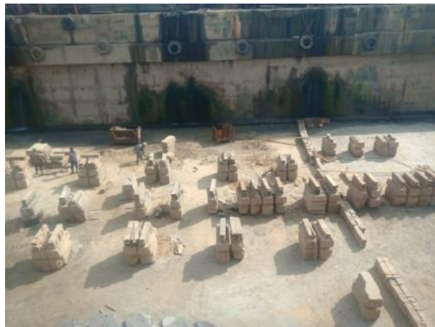
Gambar 2.14 Proses penyusunan keel block dan side block
