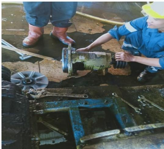
*Gambar 4.10. 4..Proses Pemasangan pompa kewpump KS-SE2
