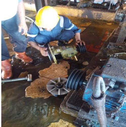
Gambar 4.10. 2.pemasangan pompa kewpump KS-SE2
