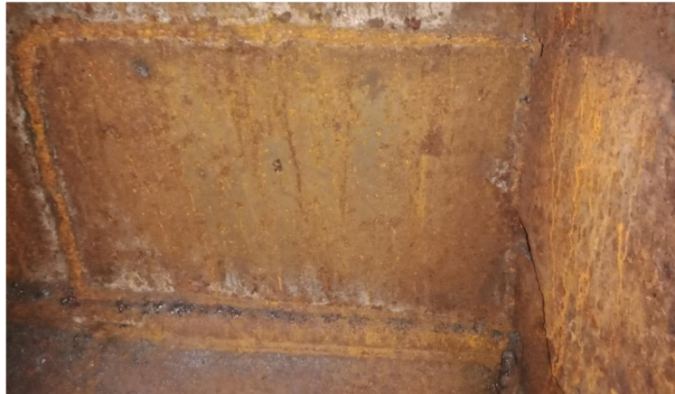
Gambar 3.3. Hasil sambungan area replating yang akan di uji
