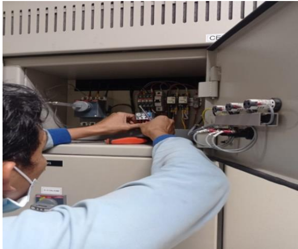
Gambar 2.17 Penggantian TOR Sumber : PT. Wilmar Bioenergi Indonesia, (2022)
