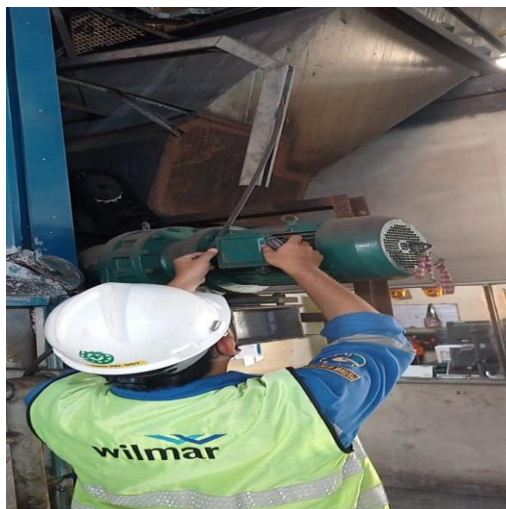
Gambar 2.30 Penggantian Gearbox Elektro Motor CF 6998 TOH Sumber : PT. Wilmar Bioenergi Indonesia, (2022)
