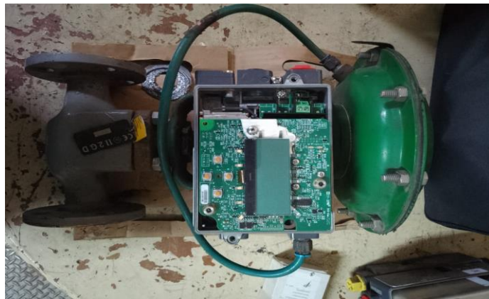
Gambar 2.11 Actuator Valve dan Positioner Sumber : PT. Wilmar Bioenergi Indonesia, (2022)
