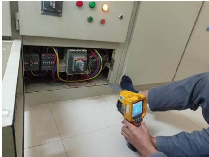
Gambar 2.27 IR Check Panel
