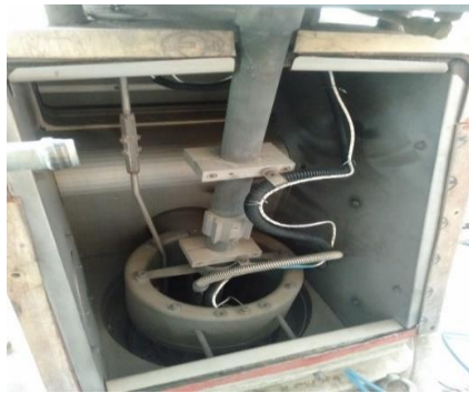
Gambar 2. 2 Perbaikan Pengapian Boiler (Sumber: PT. WINA OLEO CHEMICAL, 2022)
