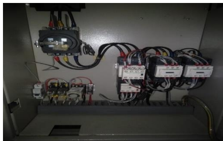
Gambar 2. 19 Pemasangan Tor ( Thermal Overload Relay ) (Sumber: PT. WINA OLEO CHEMICAL, 2022)
