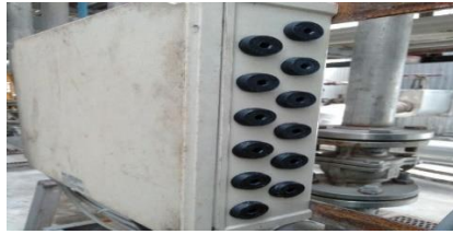
Gambar 2. 38 Pemasangan Flux Penutup (Sumber: PT. WINA OLEO CHEMICAL, 2022)
