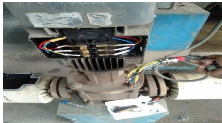
Gambar 2. 18 Pengecekan Motoran Dan Penggantian Gland (Sumber: PT. WINA OLEO CHEMICAL, 2022)
