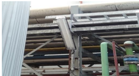
Gambar 2. 4 Penggantian Dan Pemasangan Lighting (Sumber: PT. WINA OLEO CHEMICAL, 2022)
