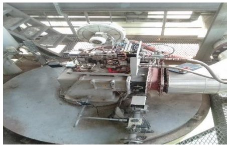
Gambar 2. 32 Perbaikan Trip Pada Burner (Sumber: PT. WINA OLEO CHEMICAL, 2022)
