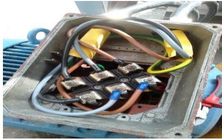
Gambar 2. 45 Pemasangan Kabel Motoran Pompa (Sumber: PT. WINA OLEO CHEMICAL, 2022)
