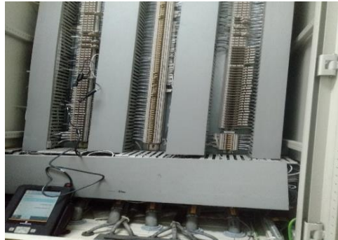
Gambar 2. 13 Pengecekan Flow Meter Menggunakan Hart (Sumber: PT. WINA OLEO CHEMICAL, 2022)
