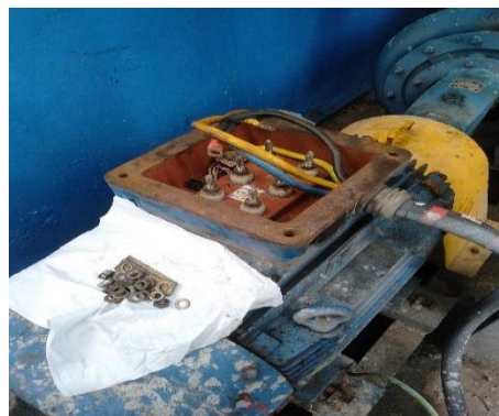
Gambar 2. 14 Pemasangan Kabel Motoran Delta (Sumber: PT. WINA OLEO CHEMICAL, 2022)
