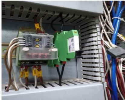
Gambar 2. 3 Pemasangan Relay Plc (Sumber: PT. WINA OLEO CHEMICAL, 2022)
