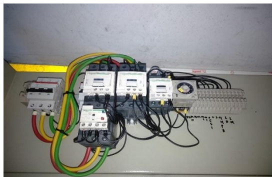
Gambar 2. 40 Pemasangan Instalasi (Sumber: PT. WINA OLEO CHEMICAL, 2022)
