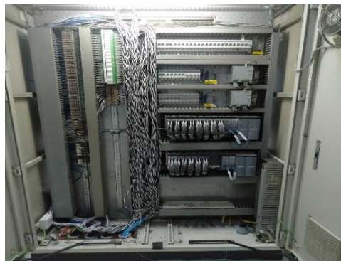
Gambar 2. 7 Pemasangan Kabel Flow Meter (Sumber: PT. WINA OLEO CHEMICAL, 2022)
