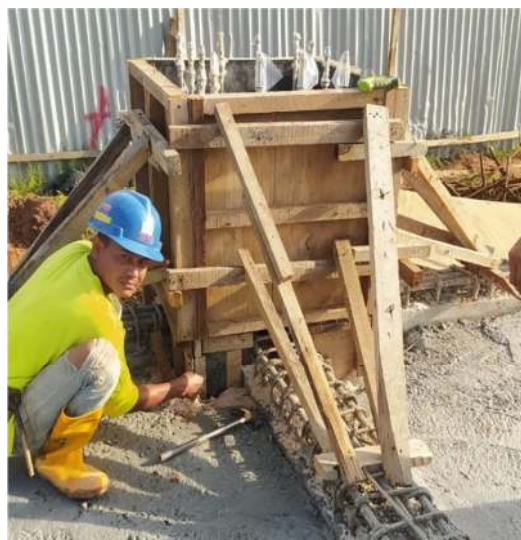
Gambar 3.22 Pemasangan Bekisting Pedestal (Sumber : Dokumentasi Pribadi, 2022 )
