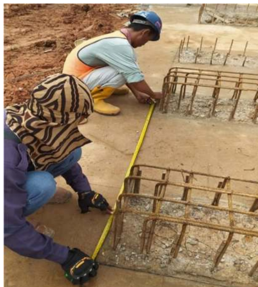
Gambar 3.19 Pemasangan Besi Equipment (Sumber : Dokumentasi Pribadi, 2022 )
