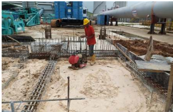
Gambar 3.14 Pemadatan Tanah (Sumber : Dokumentasi Pribadi, 2022 )
