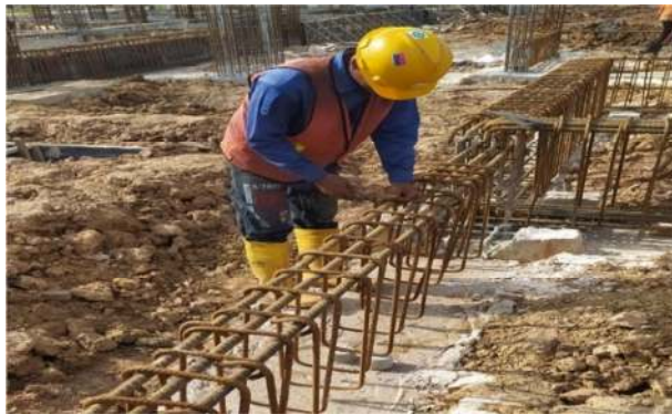
Gambar 3.10 Pembesian Tie Beam (Sumber : Dokumentasi Pribadi, 2022 )
