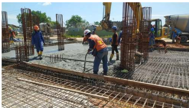
Gambar 3.17 Pengecoran Lantai (Sumber : Dokumentasi Pribadi, 2022 )
