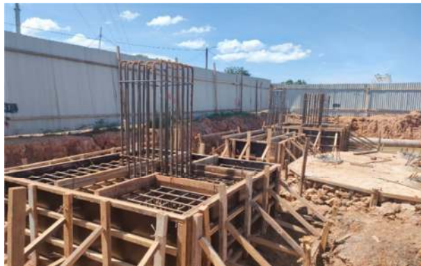
Gambar 3.8 Pemasangan Bekisting Pile Cap (Sumber : Dokumentasi Pribadi , 2022)
