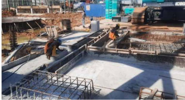
Gambar 3.20 Pemasangan Bekisting Equipment (Sumber : Dokumentasi Pribadi, 2022 )
