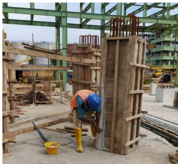
Gambar 3.23 Pemasangan Bekisting Kolom (Sumber : Dokumentasi Pribadi, 2022 )
