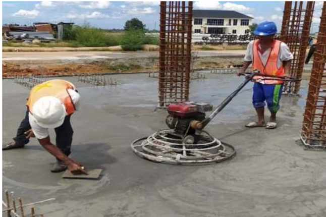
Gambar 3.18 Perataan Lantai (Sumber : Dokumentasi Pribadi, 2022 )
