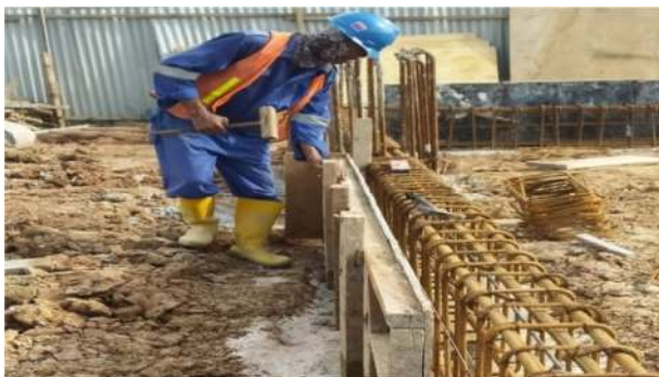
Gambar 3.11 Pemasangan Bekisting Tie Beam (Sumber : Dokumentasi Pribadi, 2022 )
