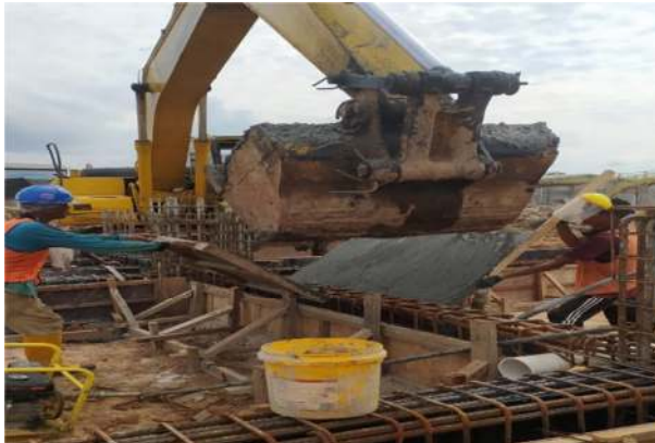
Gambar 3.12 Pengecoran Tie Beam (Sumber : Dokumentasi Pribadi, 2022 )
