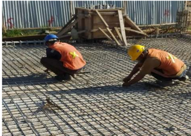
Gambar 3.16 Pembesian Lantai (Sumber : Dokumentasi Pribadi, 2022 )
