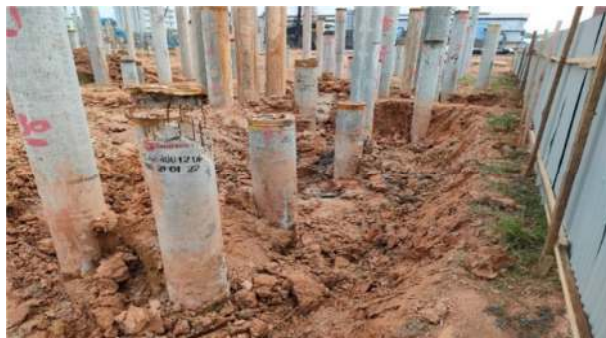
Gambar 3.5 Pengerjaan Tiang Pancang (Sumber : Dokumantasi Proyek, 2022)
