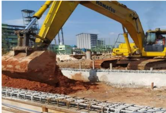
Gambar 3.13 Urugan Tanah (Sumber : Dokumentasi Pribadi, 2022 )
