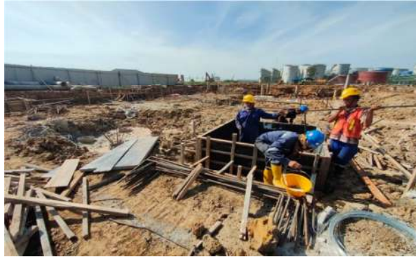
Gambar 3.7 Penulangan Pile Cap (Sumber : Dokumentasi Proyek , 2022)
