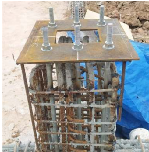
Gambar 3.21 Pemasangan Anchor Bolt (Sumber : Dokumentasi Pribadi, 2022 )
