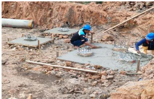
Gambar 3.6 Lean Concrete (Sumber : Dokumentasi Proyek , 2022)
