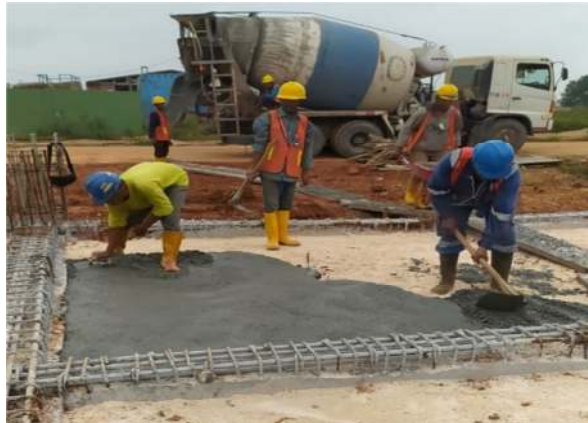
Gambar 3.15 Lean Concrete (Sumber : Dokumentasi Pribadi, 2022 )
