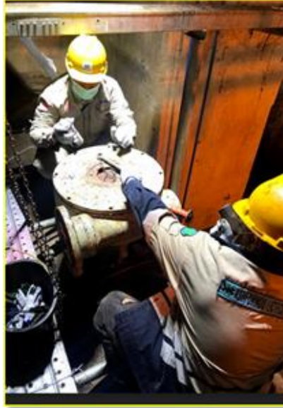
Gambar 4. 14 Lepas baut cover gearbox sisi atas Sumber: Dokumentasi Pribadi
