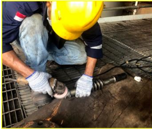
Gambar 4. 19 Cleaning part gearbox Sumber: Dokumentasi Pribadi
