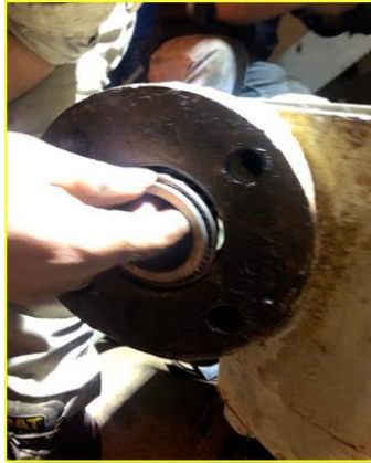
Gambar 4. 20 Pasang bearing baru sisi DE dan NDE Sumber: Dokumentasi Pribadi
