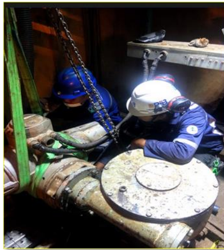
Gambar 4. 13 Pembongkaran MOV valve Sumber: Dokumentasi Pribadi
