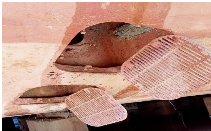
Gambar 2.37 Pengecekan pada lubang Sea Chest
