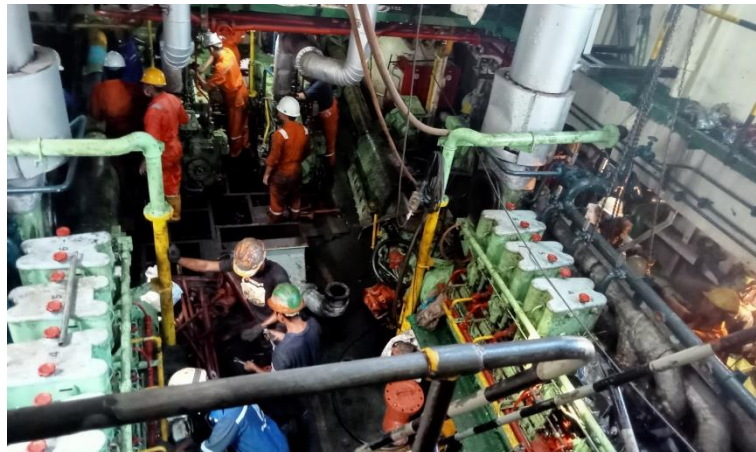
Gambar 2.31 Pengecekan Pada Ruang Mesin
