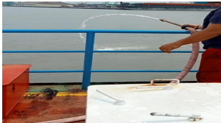
Gambar 2.8 Pengetesan pada Nozzel Hydrant Kapal
