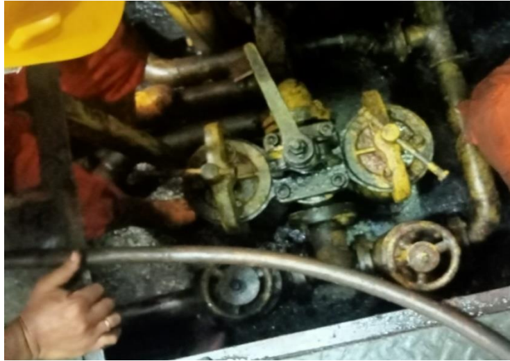
Gambar 2.30 Pengecekan Pada Pipa Pelumas
