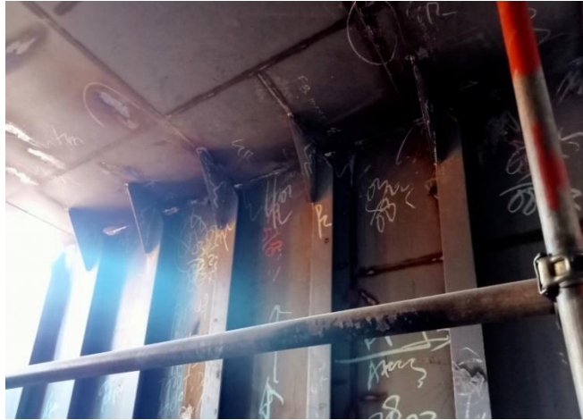
Gambar 2.34 Susunan Bracket
