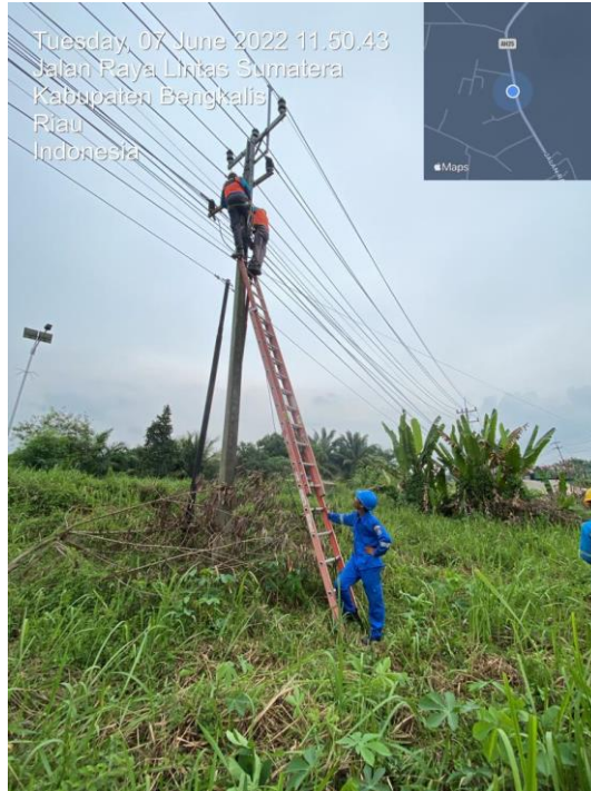
Lampiran 1. Gambar Pemasang klem pipa tiang listrik beton.
