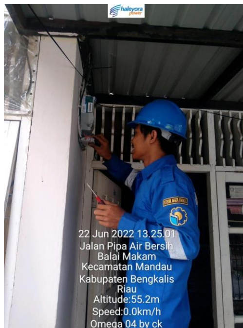
Lampiran 2. Gambar Mengganti MCB KWH Meter Digital.
