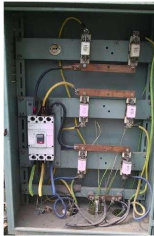
Gambar 3.9 Bentuk fisik PHB-TR
