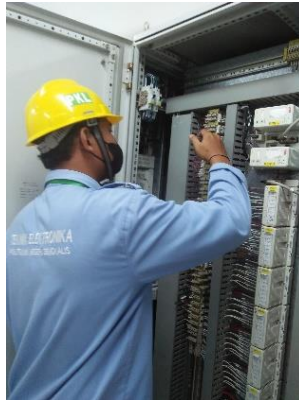
Gambar 2.12 Pengecekan chanel ECM (Sumber : Dokumentasi PT. Indah Kiat pulp & paper Tbk Perawang, 2022)
