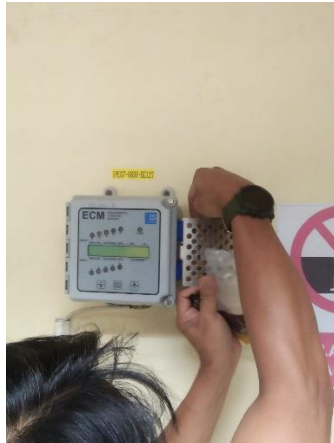
Gambar 2.14 penggantian sensor ECM (Sumber : Dokumentasi PT. Indah Kiat pulp & paper Tbk Perawang, 2022)
