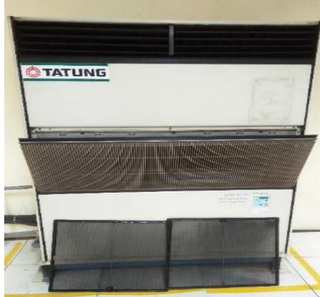
Gambar 2.19 membersihkan filter pendingin ruangan (Sumber : Dokumentasi PT. Indah Kiat pulp & paper Tbk Perawang, 2022)
