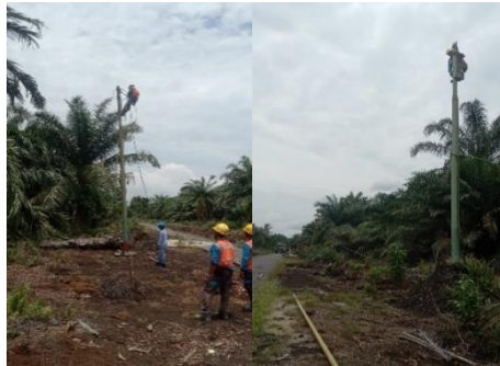
Gambar 2.43 Menaikan Kabel SKU jatuh (Sumber : Dokumentasi Penulis, 2022)
