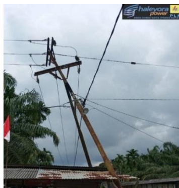
Gambar 2.18 Memperbaiki Tiang Condong (Sumber : Dokumentasi penulis, 2022)
