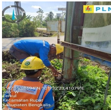
Gambar 2 3.Pemasangan Grounding (Sumber : Dokumentasi Penulis, 2022)
