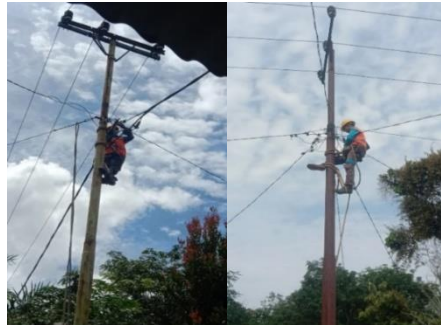
Gambar 2.14 Menyambungkan Kabel SR (Saluran Rumah)
