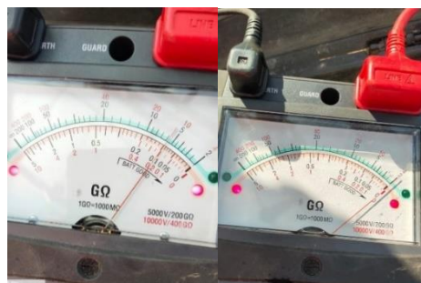
Gambar 2.33 Pengukuran Grounding (Sumber : Dokumentasi Penulis, 2022)
