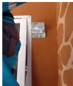
Gambar 2.45 Menggantikan MCB Rusak (Sumber : Dokumentasi Penulis, 2022)
