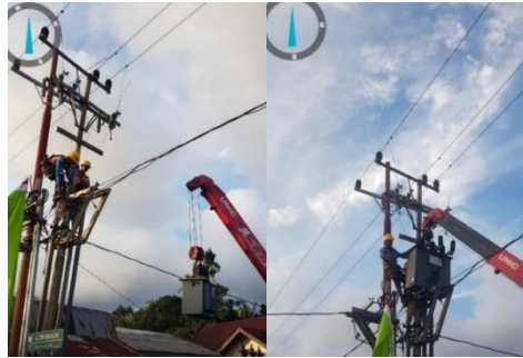
Gambar 2.30 Proses pergantian trafo gardu (Sumber : Dokumentasi Penulis, 2022)
