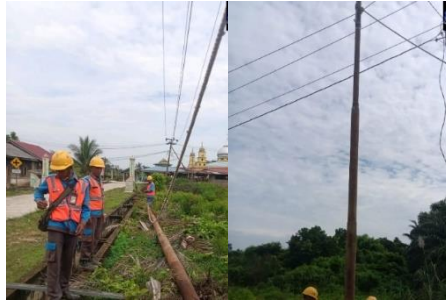
Gambar 2.34 Menggantikan Tiang (Sumber : Dokumentasi penulis, 2022)
