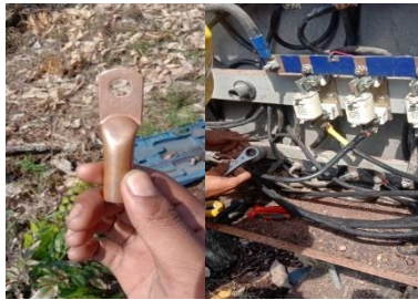
Gambar 2.46 Menggantikan Pin Copper (Sumber : Dokumentasi Penulis, 2022)
