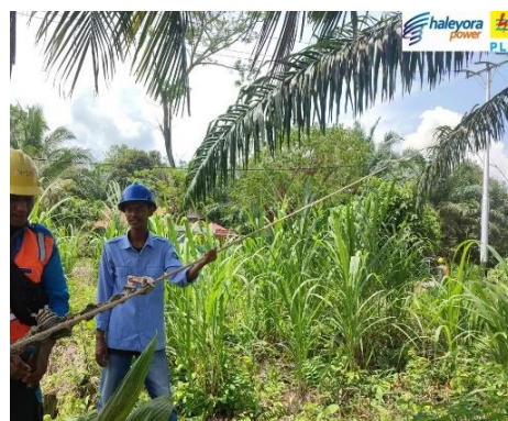
Gambar 2.11 Memperbaiki Tiang Yang Condong
