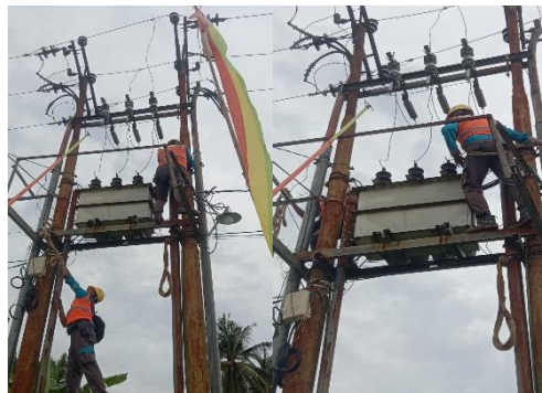
Gambar 2.42 Menggantikan Trafo (Sumber : Dokumentasi Penulis, 2022)
