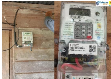
Gambar 2.19 Memasang Kwh Meter Baru (Sumber : Dokumentasi penulis, 2022)
