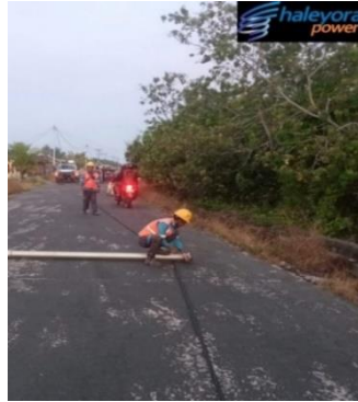
Gambar 2.17 memperbaiki tiang tumbang (Sumber : Dokumentasi penulis, 2022)
