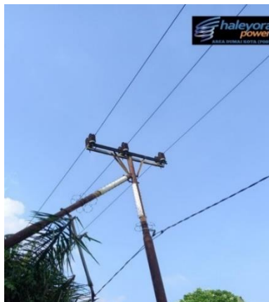
Gambar 2.20 Memasang Kawat urai (Sumber : Dokumentasi Penulis, 2022)
