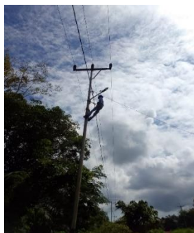
Gambar 2.26 Pemasangan Lampu Jalan Otomatis
