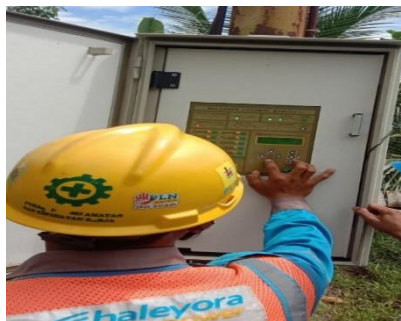
Gambar 2.2 Siaga Pada Recloser Trip (Sumber : Dokumentasi Penulis, 2022)
