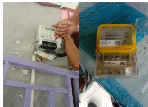
Gambar 2.10 Pergantian kWh Meter ke meter sementara (Sumber : Dokumentasi Penulis, 2022 )
