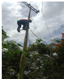
Gambar 2.47 Menyambung Kabel SR Putus (Sumber : Dokumentasi Penulis, 2022)
