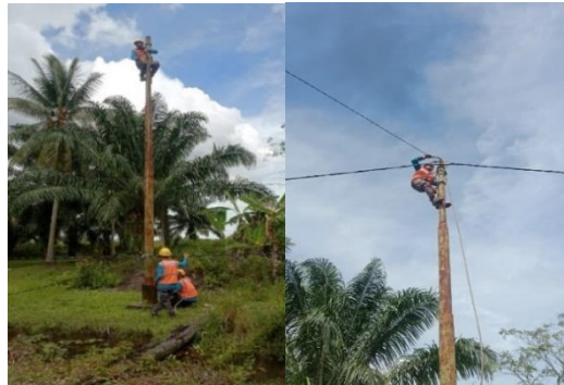
Gambar 2.9. Menaikkan Kabel SKU dan Kabel SR (Sumber : Dokumentasi Penulis, 2022)
