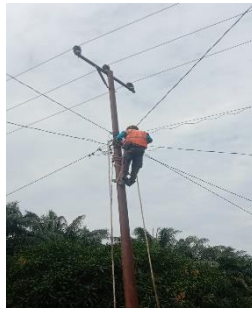
Gambar 3.2 Proses Pemasangan pierching
