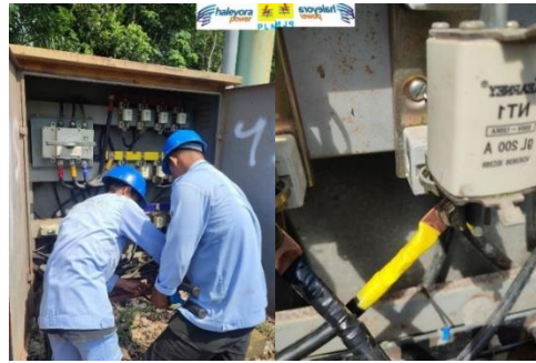
Gambar 2.38. menggantikan Pin copper (Sumber : Dokumentasi Penulis, 2022)
