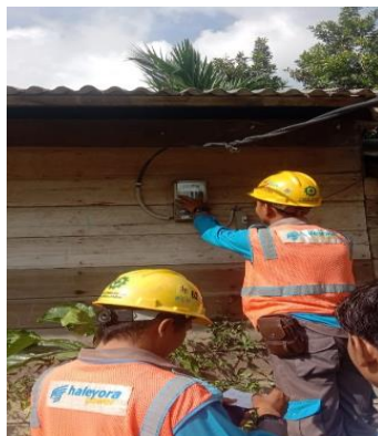
Gambar 2.8 Memasukan kode CT( Clear Tamper ) (Sumber : Dokumentasi Penulis, 2022)
