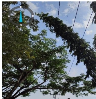
Gambar 3.1. Pohon Menyentuh Kabel (Sumber Dokumentasi Penulis 2022)
