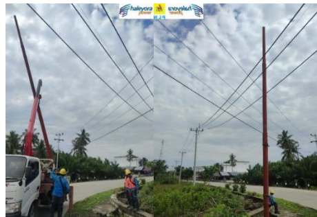
Gambar 2.36 Proess Pergantian Tiang (Sumber : Dokumentasi Penulis, 2022)
